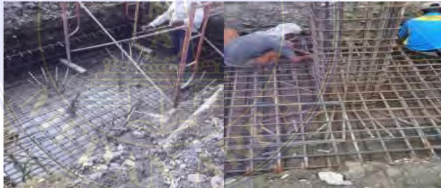
Gambar 9. Penulangan *Pile Cap*
