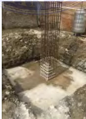
Gambar 11. Pelepasan *Bekisting*
