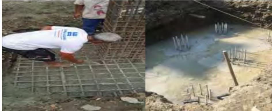
Gambar 10. Pengecoran *Pile Cap*
