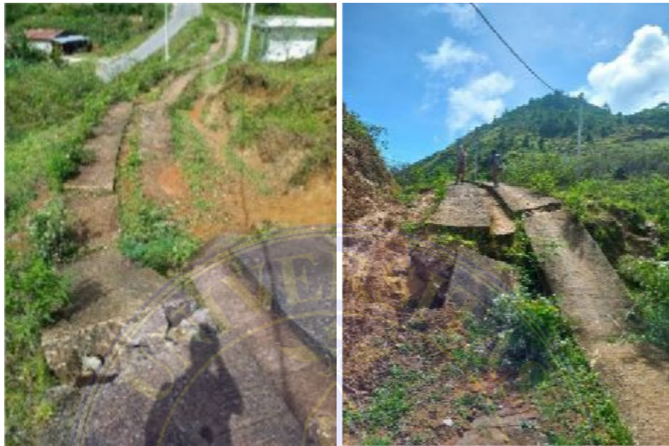
Gambar 3. 10 Kondisi struktur Jalan menuju ke puncak Bukit Maranak
