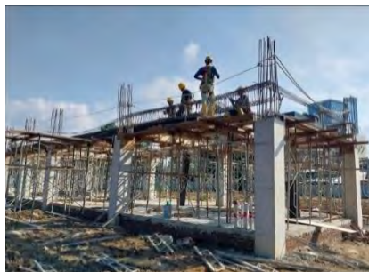
Gambar 4.4 penulangan balok
