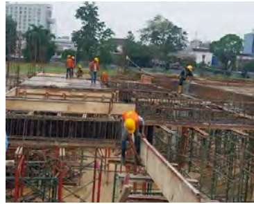
Gambar 4.3 pemasangan bekisting
