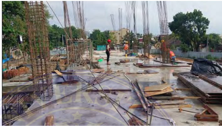
Gambar 4.5 proses pelepasan bekisting
