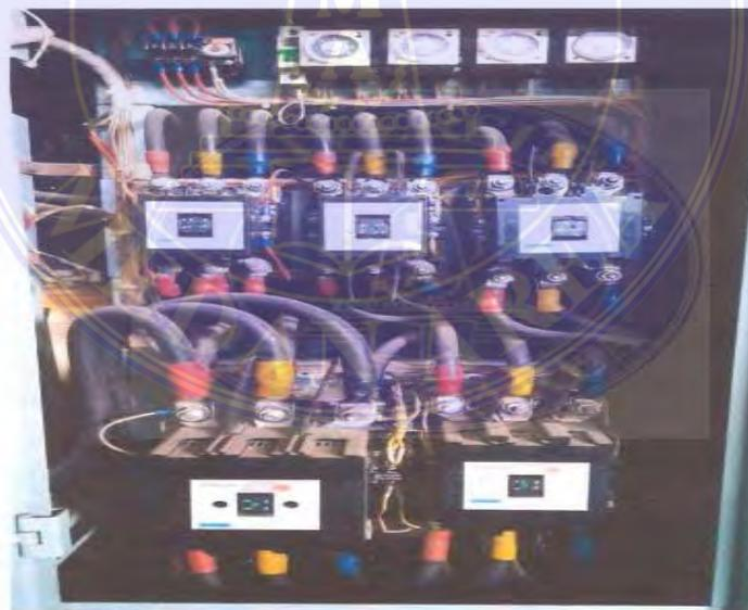
Gambar 2.14: Fisik Rangkaian Kontrol Ototrafo
