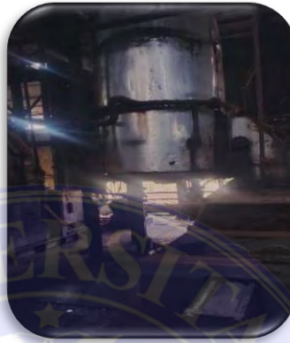
Gambar 14. Digester (Sumber : Dok. Kelompok, 2024)
