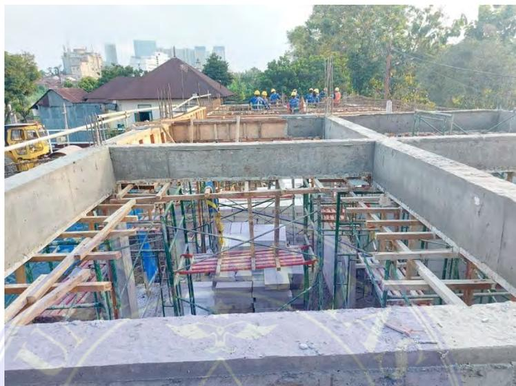
Gambar 27. Setelah Pelepasan *Bekisting*
