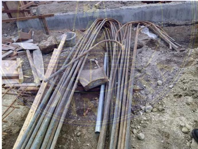
Gambar 7. besi berukuran 12 mm
