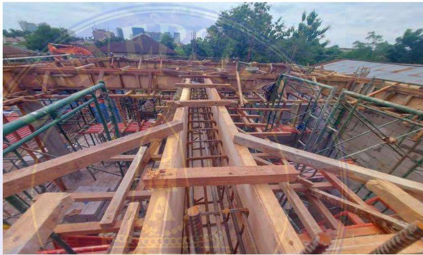
Gambar 26. *Bekisting*Balok
