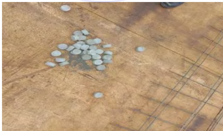
Gambar 22. Beton Decking (Sumber : Dokumentasi Pribadi, 2023)
