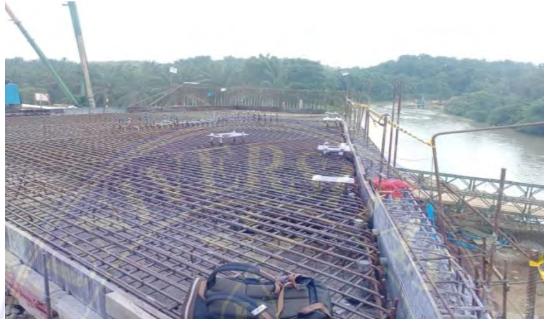
Gambar 35. Bekisting (Sumber : Dokumentasi pribadi, 2023)
