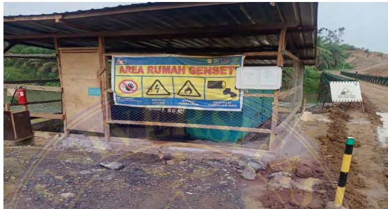
Gambar 12. Genset (Sumber : Dokumentasi pribadi, 2023)
