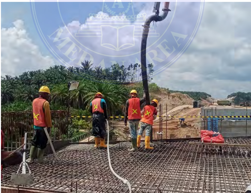
Gambar 2. Pengecoran Pelat Injak
