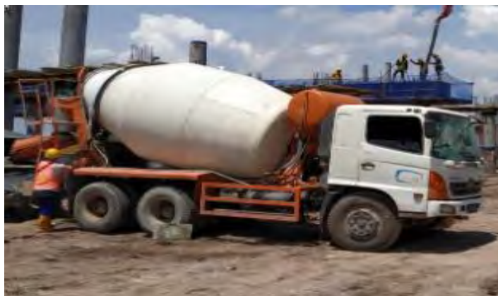
Gambar 9. Truk Mixer (Sumber : Dokumentasi pribadi, 2023)
