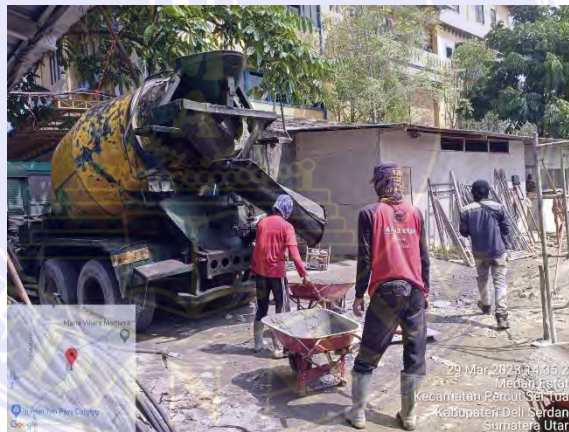
Gambar 3. 9 Truck Mixer Beton Sumber : Dokumen Lapangan
