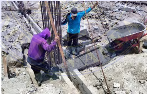
Gambar 4.5.6 : Pengecoran Sumber : Dokumentasi Lapangan
