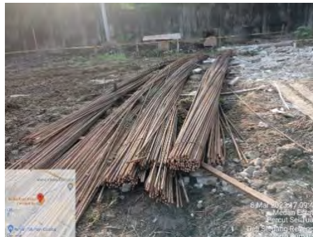
Gambar 3. 36 Besi Tulangan Sumber : Dokumen Lapangan
