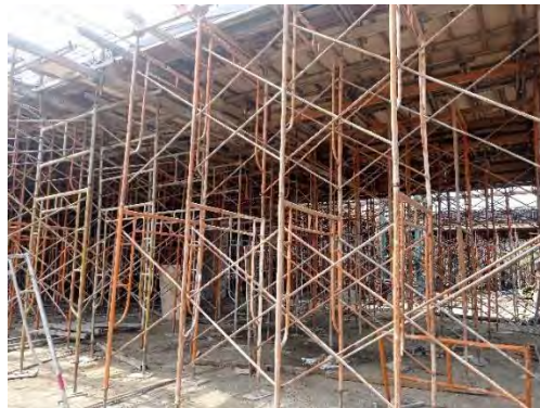
Gambar 3. 18 Scaffolding Sumber : Dokumen Lapangan
