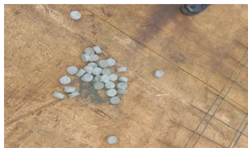
Gambar 3. 41 Beton Decking Sumber : Dokumen Lapangan
