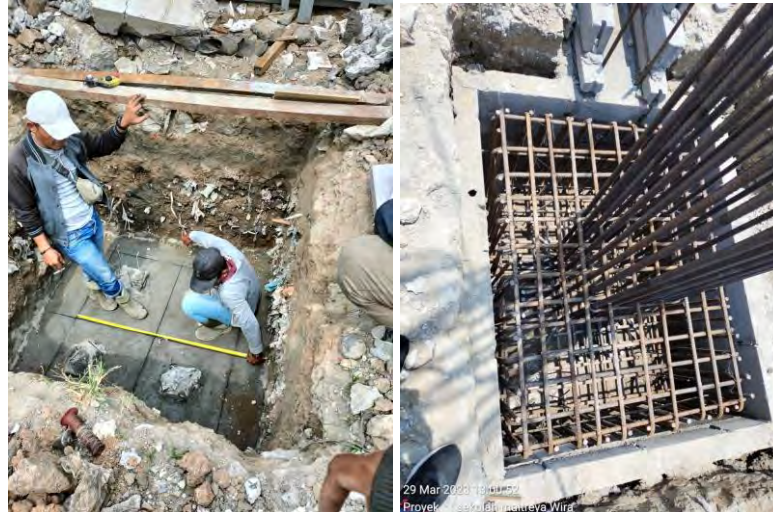
Gambar 4.5.4 : Pekerjaan Urungan Pasir, Bekisting serta Lantai Kerja Sumber : Dokumentasi Lapangan
