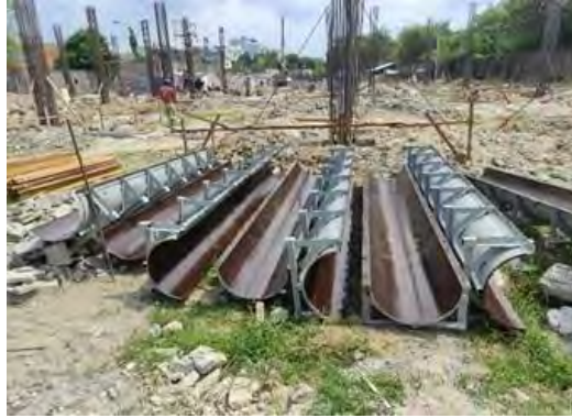
Gambar 3. 8 Bekisting Sumber : Dokumen Lapangan
