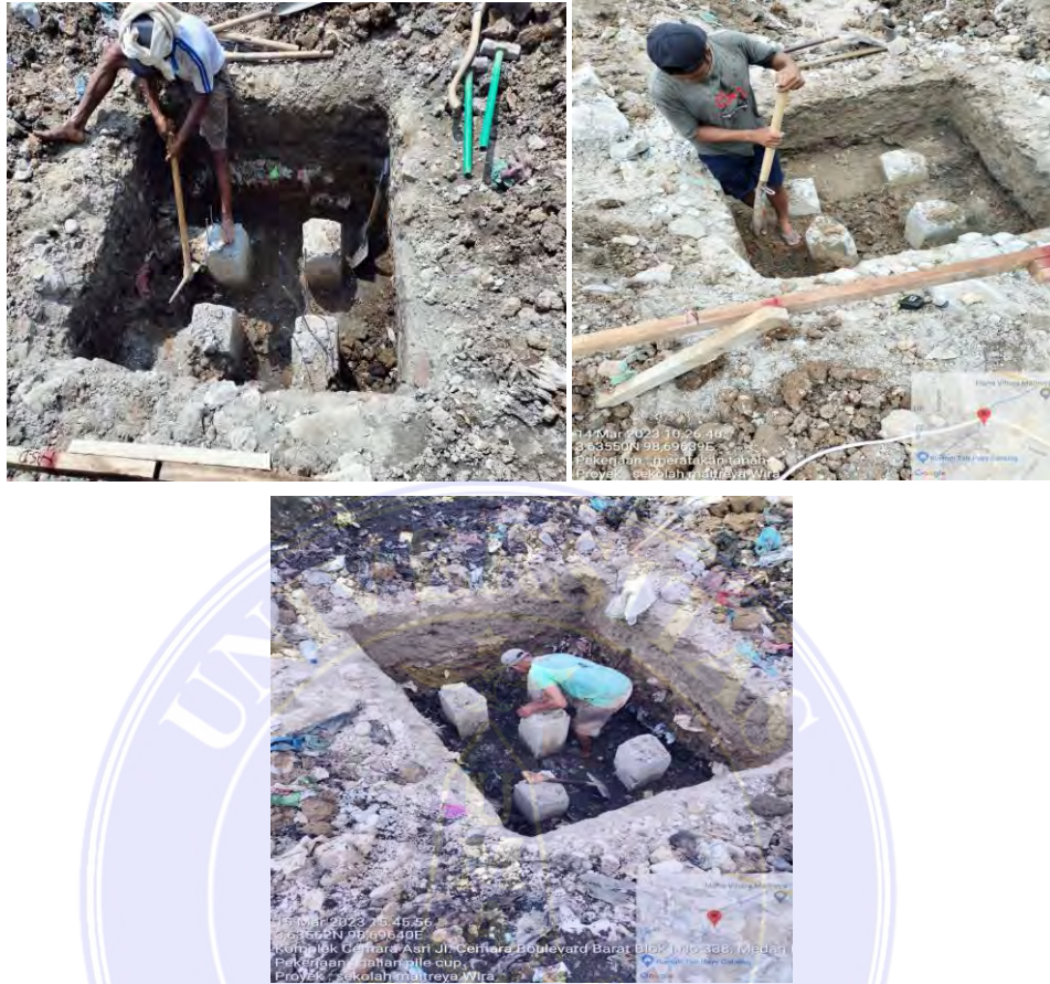
Gambar 4.5.2 : Penggalian Tanah Sumber : Dokumentasi Lapangan
