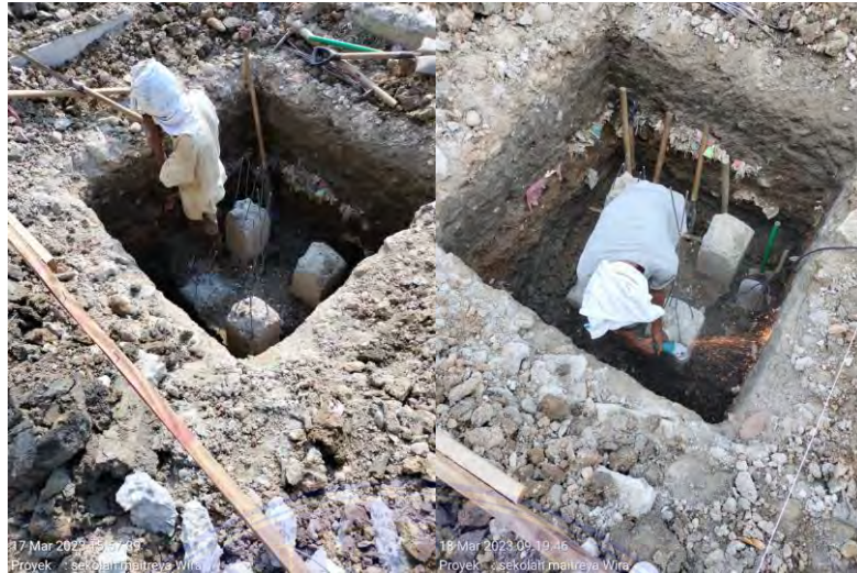
Gambar 4.5.3 : Pemotongan Tiang Pancang Sumber : Dokumentasi Lapangan
