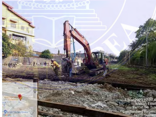
Gambar 3. 3 Excavator Sumber : Dokumen Lapangan.
