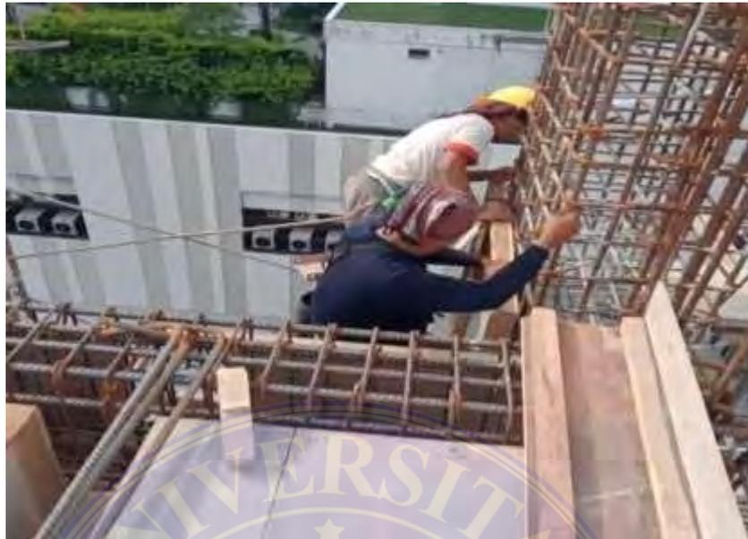
Gambar .1.Pemasangan bekisting kolom
