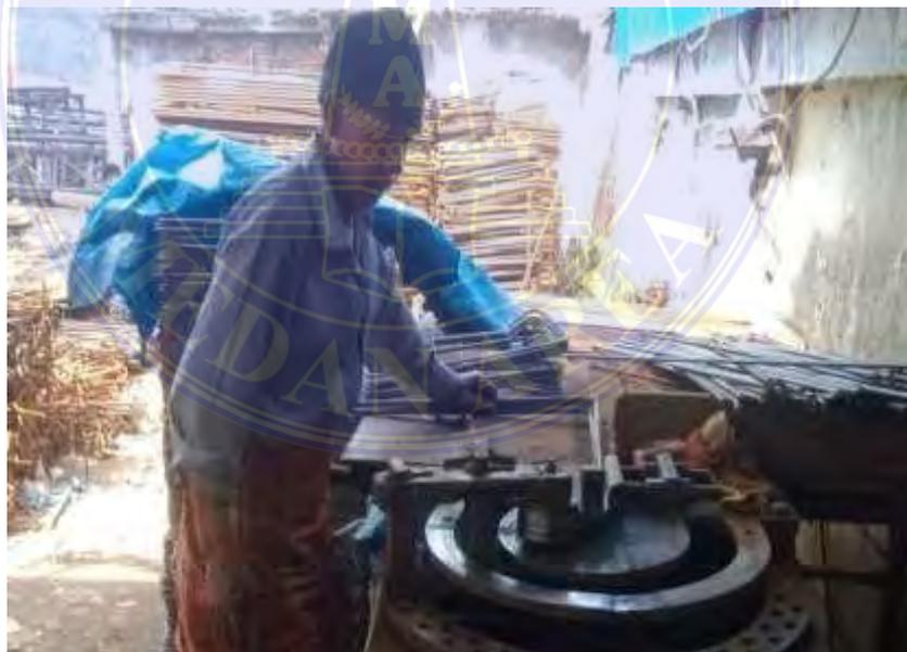
Gambar .2. Pemotongan sengkang kolom
