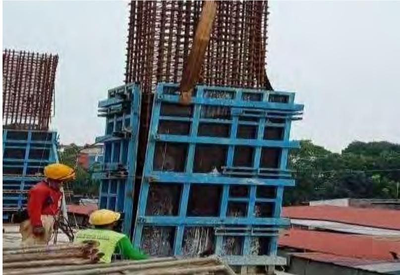
Gambar 4. 3 Pemasangan Bekisting Kolom
