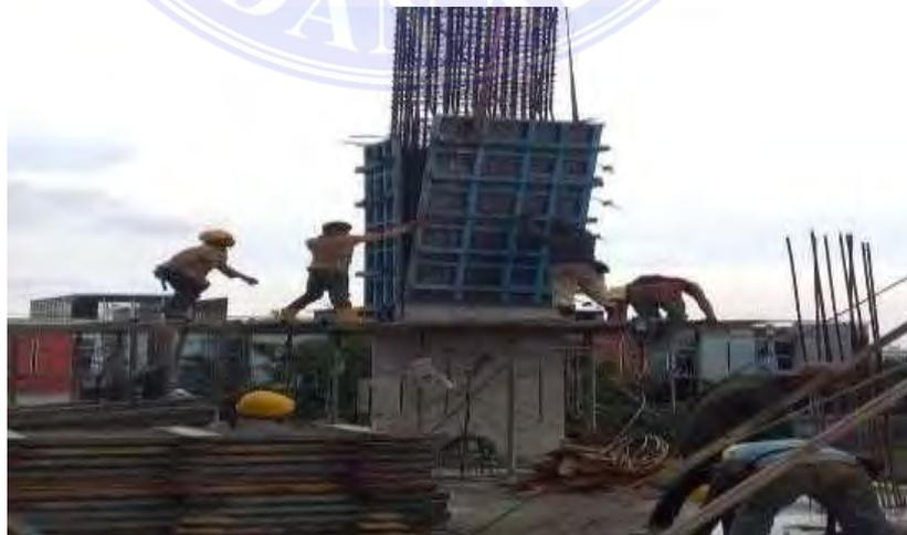
Gambar 4. 4 Pembongkaran Bekisting Kolom
