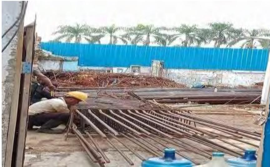
Gambar.3. Perakitan penulangan pada kolom
