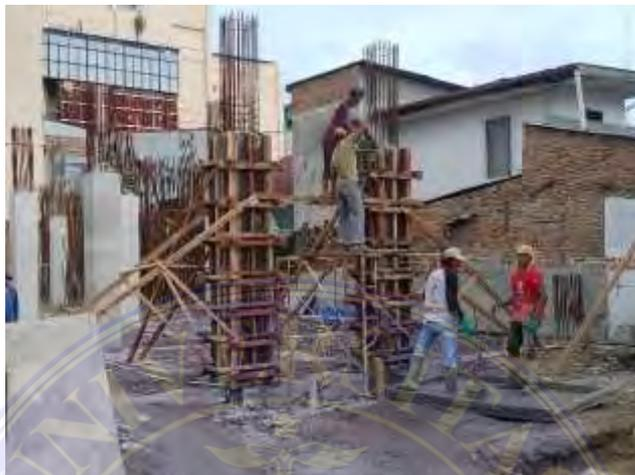
Gambar 3. 8 Bekisting pada kolom
