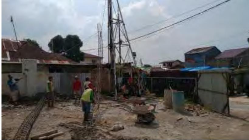
Gambar 4. 6 Pemasangan Keranjang Besi
