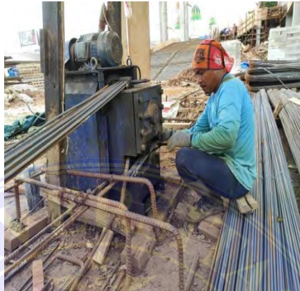
Gambar 4.2. Pemotongan besi tulangan Sumber: Data Lapangan 2023
