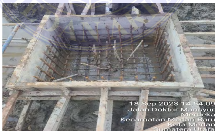
Gambar 4.7. Pemasangan beton decking Sumber: Data Lapangan 2023
