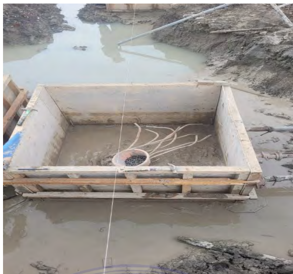
Gambar 4.4. Perakitan Bekisting
