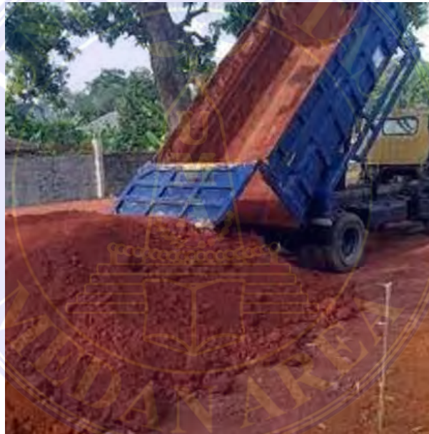
Gambar 2.25 Tanah Timbunan Sumber: Data Lapangan 2023
