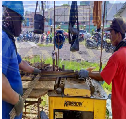
Gambar 4.3. Pembengkokan besi tulangan Sumber: Data Lapangan 2023
