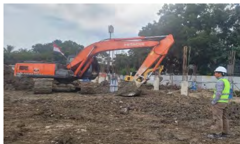
Gambar 2.3 Excavator Sumber: Data Lapangan 2023
