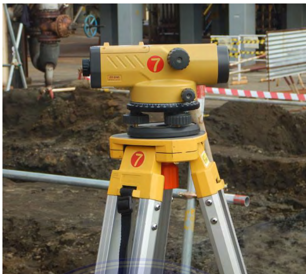
Gambar 2.5 Waterpass Sumber: Data Lapangan 2023
