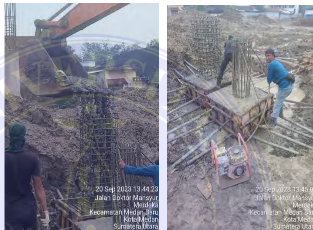
Gambar 4.13. Proses Pengecoran pile cap
