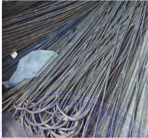
Gambar 2.18 Besi Tulangan Sumber: Data Lapangan 2023
