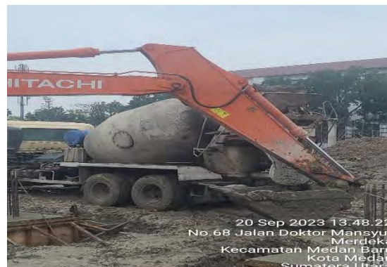
Gambar 4.12. Pemindahan beton ready mix ke excavator
