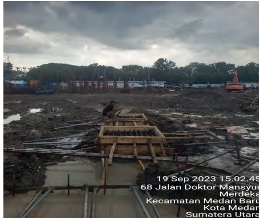
Gambar 4.10. Pemasangan penyangga bekisting
