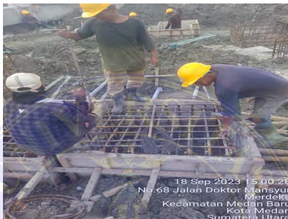
Gambar 4.6. Perakitan tulangan Pile Cap Sumber: Data Lapangan 2023
