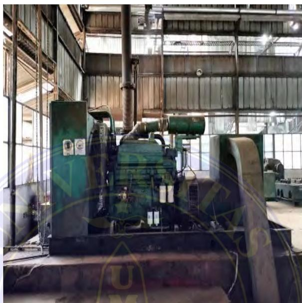
**Gambar 3. 30. Generator Diesel**
