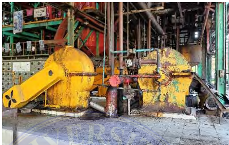
Gambar 3.42 Sludge Centrifuge
