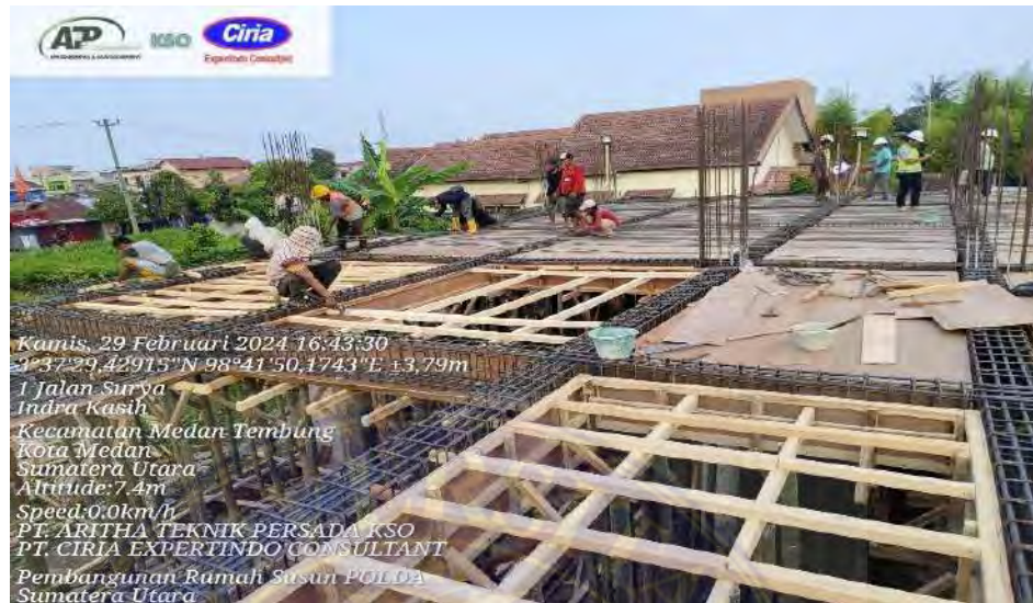
Gambar 8. Pengerjaan penulangan struktur atas (Dokumentasi lapangan, 2024)
