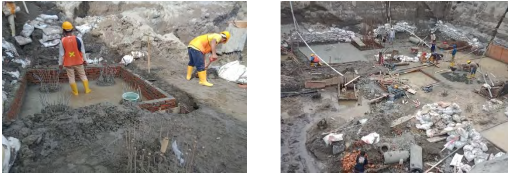
Gambar 4.8 Pekerjaan Urungan Pasir, Bekisting serta Lantai kerja Sumber : Dokumen Lapangan
