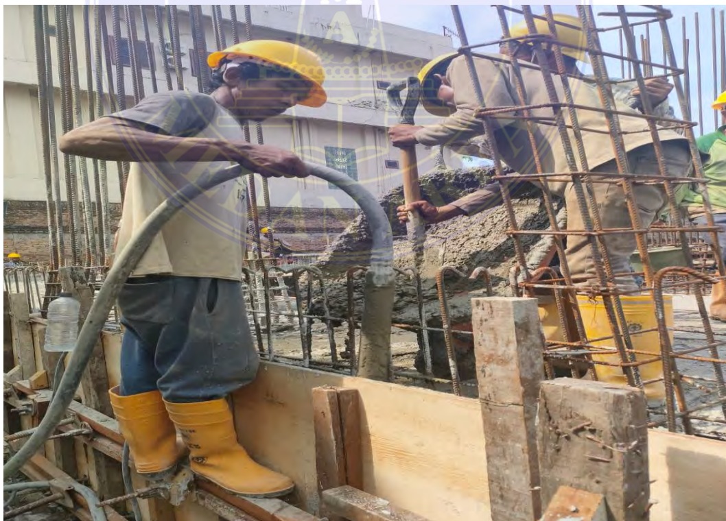
Gambar 4.4 Pekerjaan Pengecoran
