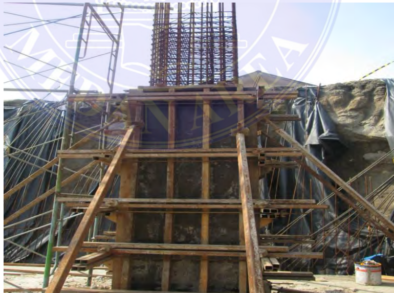
Gambar 4.3 Pekerjaan Bekisting
