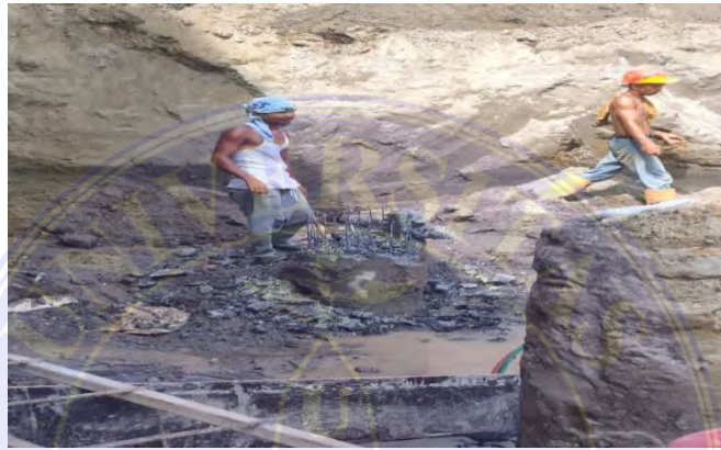
Gambar 4.7 Pemotongan Tiang Pancang
