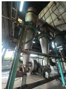
**Gambar 3. 28 *Dust Collector* (Pengumpul Debu)**
