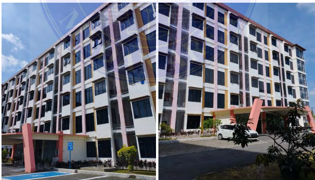
Gambar 3.2 Bentuk Tampak Gedung Sumber : (Foto Pribadi)
