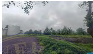
Gambar 3. 48. Aerobic Pond atau Final Pond
