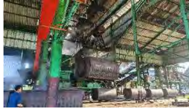
Gambar 3. 8. Lori di Angkut Hoisting Crane
