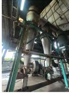
**Gambar 3. 28 Dust Collector (Pengumpul Debu)**
