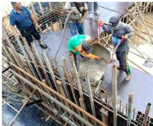
Gambar 4.5. Pengecoran Dinding (Data Lapangan, 2025)
