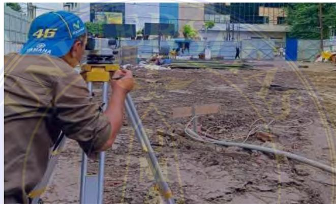
Gambar 3.30 Penentuan Titik *Pile Cap* (Dokumentasi Proyek, 2025)
