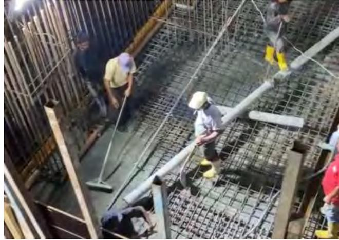
Gambar 3.34 Pengecoran (Dokumentasi Proyek, 2025)
