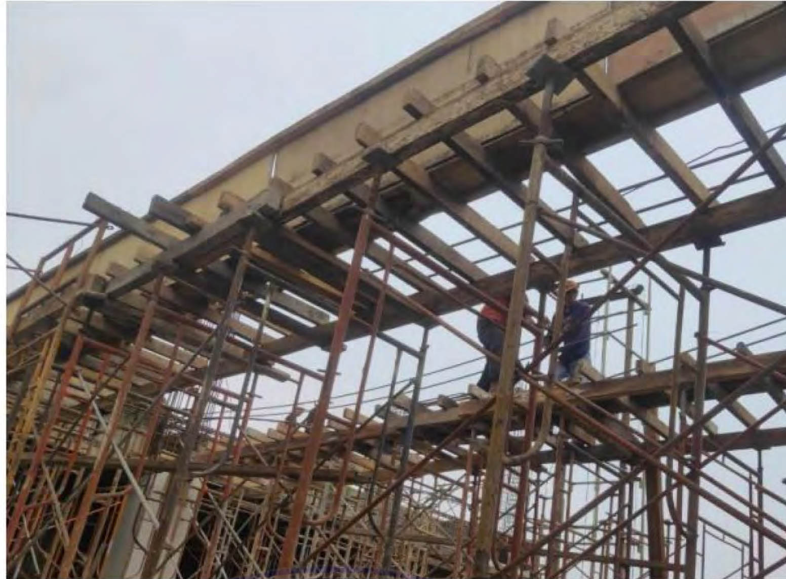
Gambar 3. 8 Bekisting Sumber : Data Lapangan
