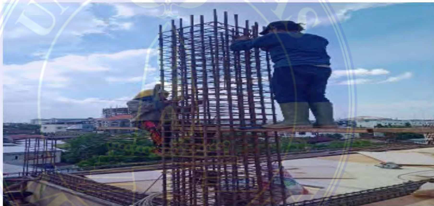
Gambar 4. 3 Penulangan Kolom
