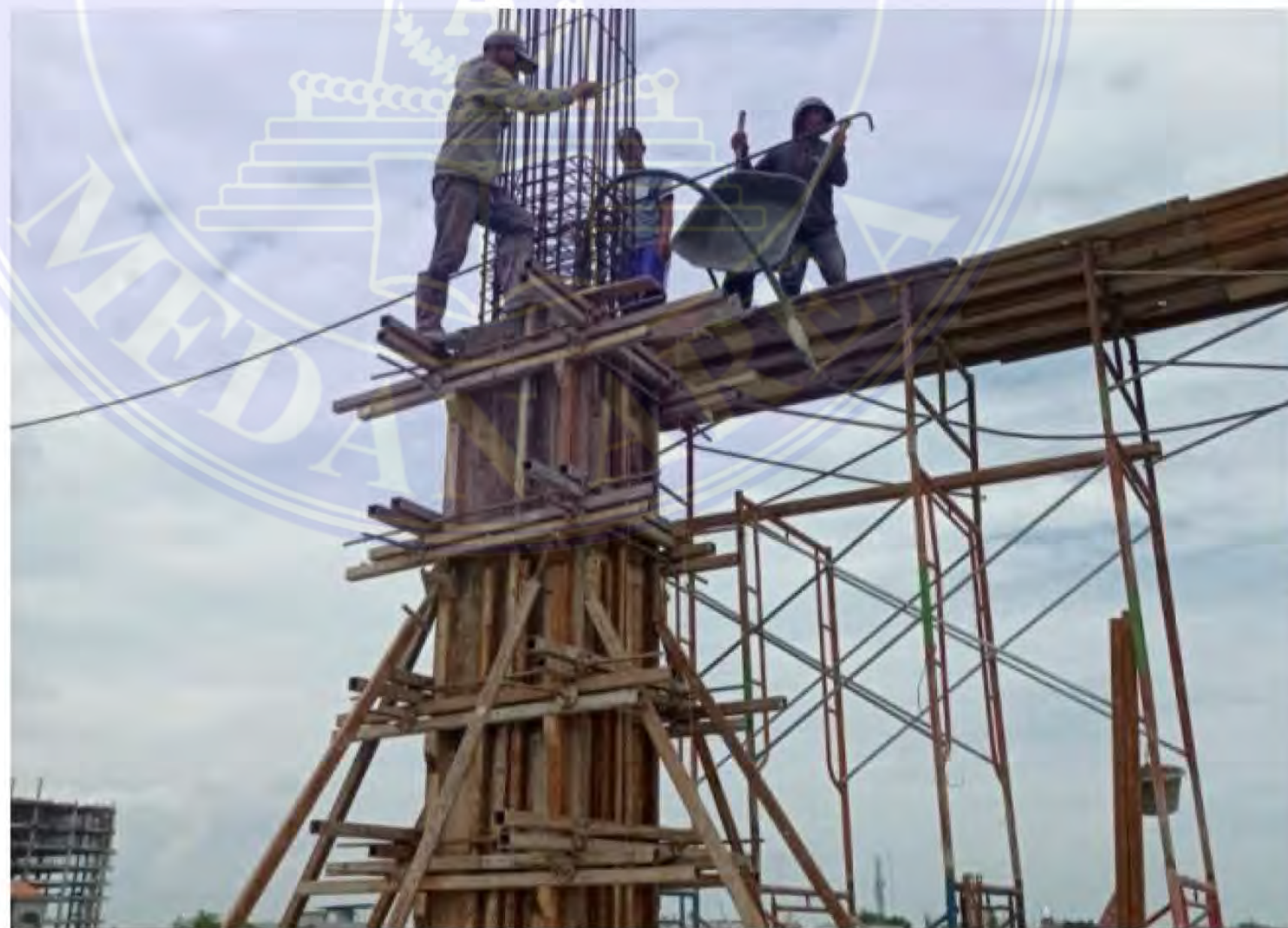
Gambar 4.5 Pengecoran Kolom
