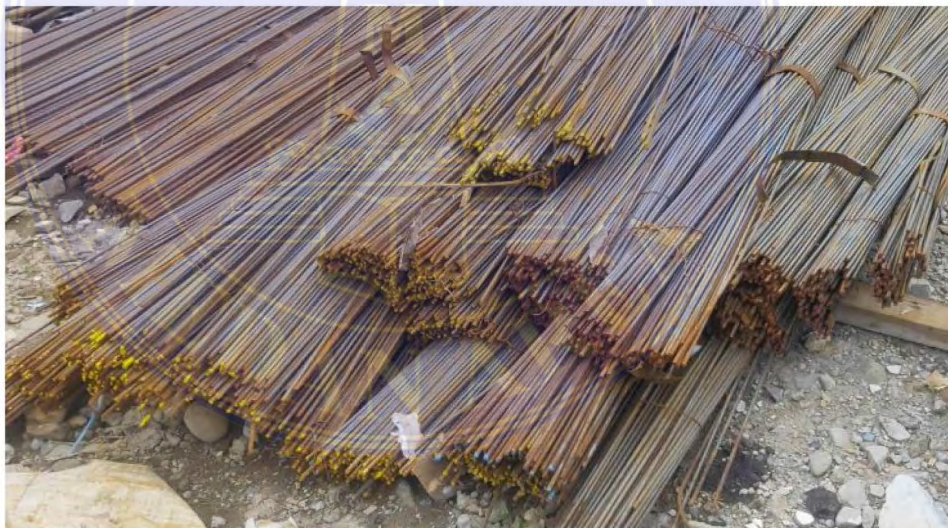
Gambar 3. 33 Besi Tulangan Sumber : Data Lapangan
