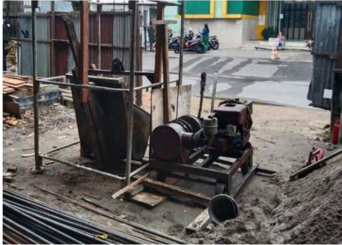
Gambar 3. 30 Bucket Cor Sumber : Data Lapangan
