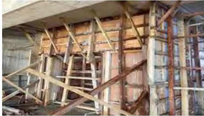
Gambar 3. 8 Bekisting (Dokumentasi Proyek, 2025)
