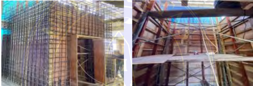
Gambar 4. 2 Pemasangan Bekisting Dinding Geser (Dokumentasi Proyek, 2025)
