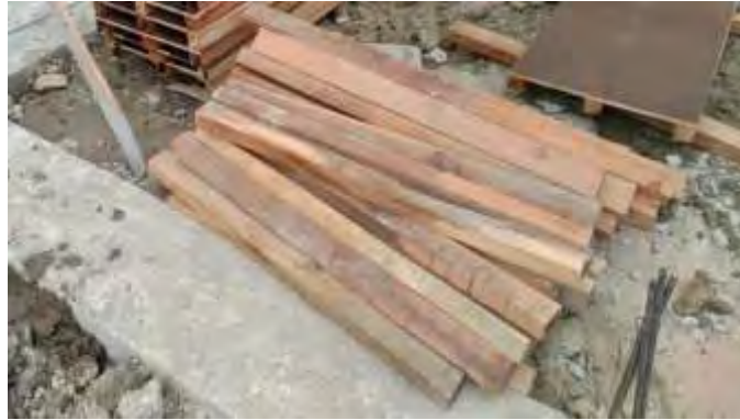
Gambar 3. 28 Kayu (Dokumentasi Proyek, 2025)
