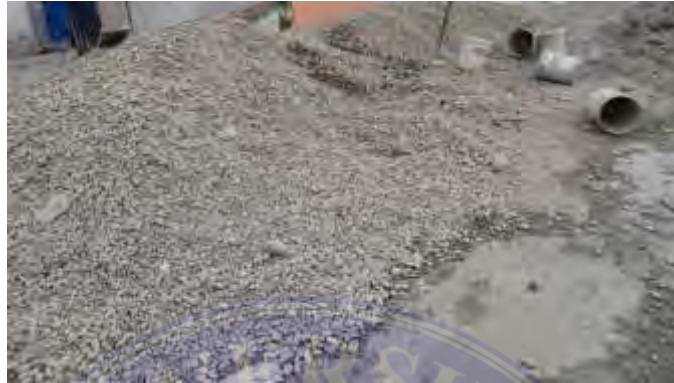
Gambar 3. 25 Agregat (Batu Pecah) (Dokumentasi Proyek, 2025)
