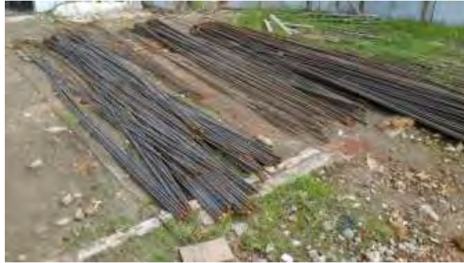
Gambar 3. 22 Besi Tulangan (Dokumentasi Proyek, 2025)
