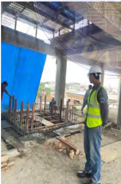
Mengamati Pemasangan Bekisting Dinding Geser
