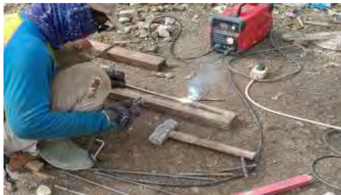
Gambar 3. 12 Las Listrik (Dokumentasi Proyek, 2025)
