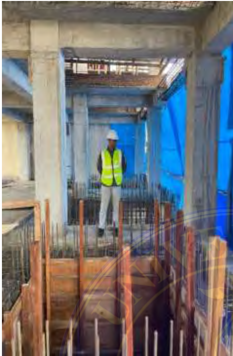
Bekisting Dinding Geser Selesai Terpasang
