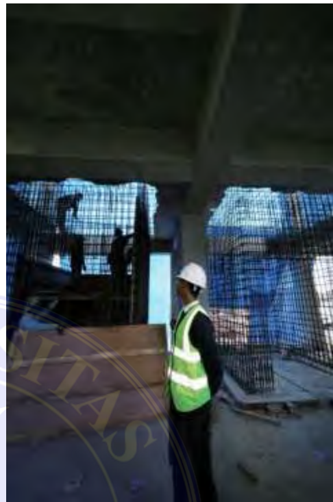
Pekerjaan Penulangan Dinding Geser
