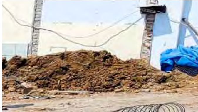
Gambar 3. 26 Tanah Timbunan (Dokumentasi Proyek, 2025)
