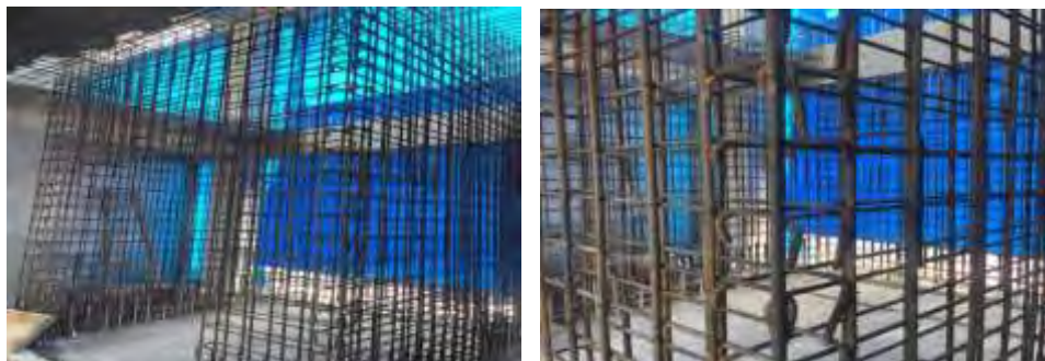
Gambar 4. 1 Pembesian Dinding Geser (Dokumentasi Proyek, 2025)
