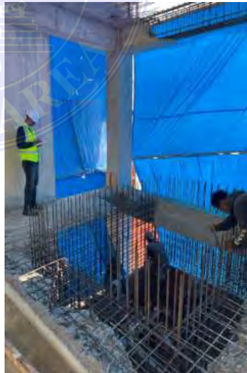
Menyesuaikan Jarak Antar Tulangan Dinding Geser
