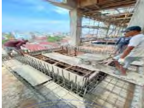
Gambar 4. 3 Pelaksanaan Pengecoran Dinding Geser (Dokumentasi Proyek, 2025)
