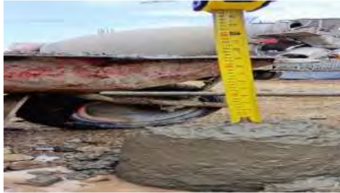
Gambar 3. 2 Meteran (Dokumentasi Proyek, 2025)
