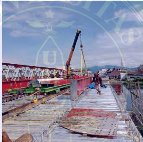
Gambar 3.3 Crane duduk/*lifting equipment* (Dokumentasi Proyek 2025).
