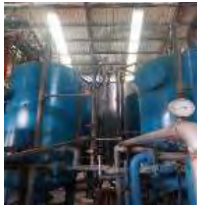
Gambar 3. 48 Tangki Kation Yang Bagian Sebelah Kanan
