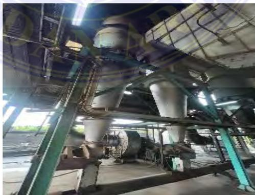
**Gambar 3. 28 Dust Collector (Pengumpulan Debu)**
