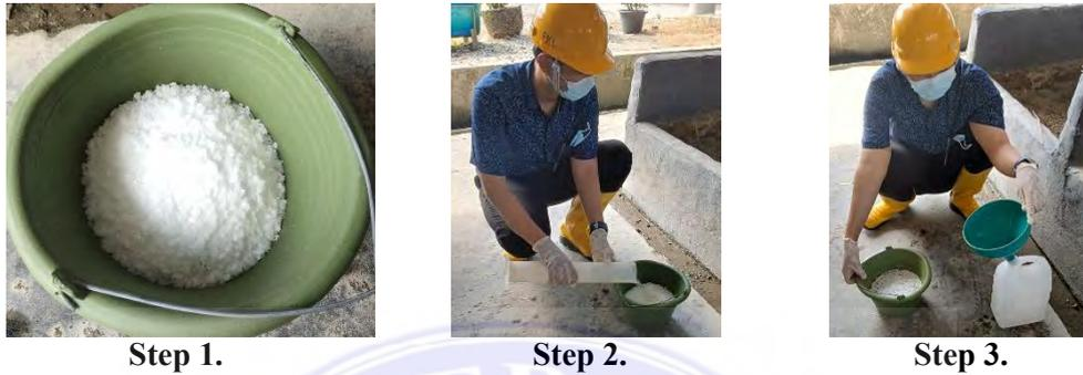
Gambar 5. Langkah-langkah pembuatan larutan NaOH
