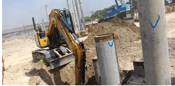
Gambar 3.1. Excavator (Dokumentasi Proyek, 2025)
