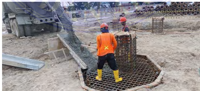
Gambar 3.2. Truck Mixer (Dokumentasi Proyek, 2025)
