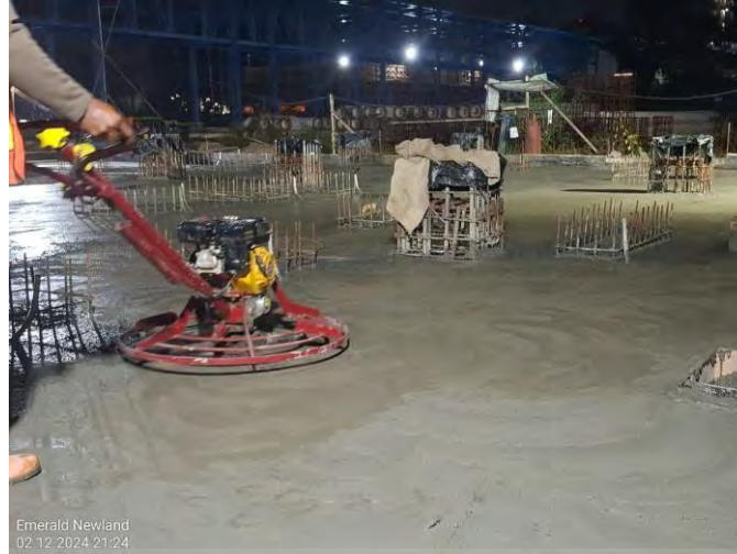
Gambar 3.8. Power Trowel (Dokumentasi Proyek, 2025)
