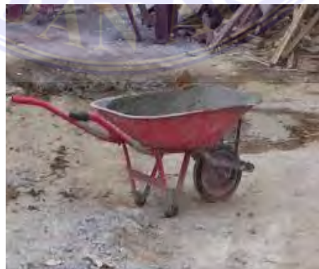
Gambar 3.9. Kereta sorong (Dokumentasi Proyek, 2025)
