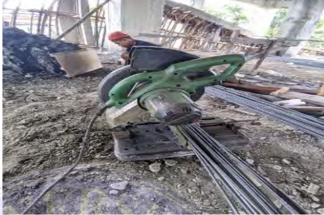
Gambar 4. 1. Pemotongan besi tulangan
