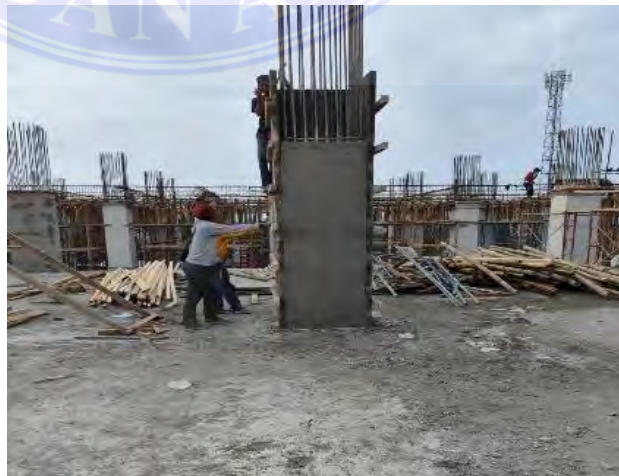
Gambar 4.9. Pembongkaran bekisting
