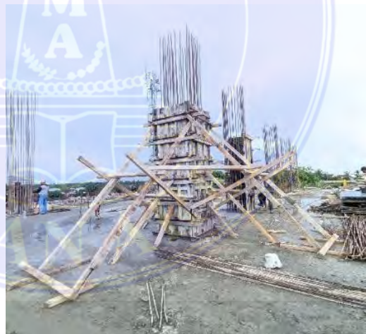
Gambar 4. 7. Penyangga bekisting kolom
