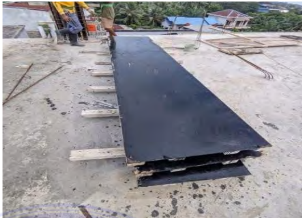
Gambar 4. 3. Bekisting kolom
