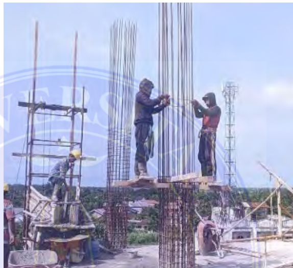
Gambar 4. 5. Pemasangan sengkang
