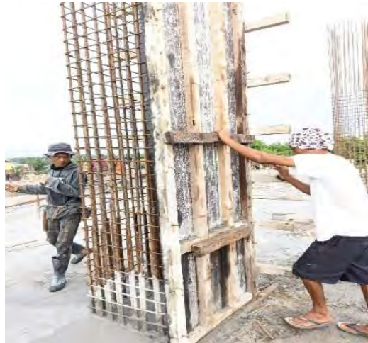
Gambar 4. 6. Perakitan bekisting
