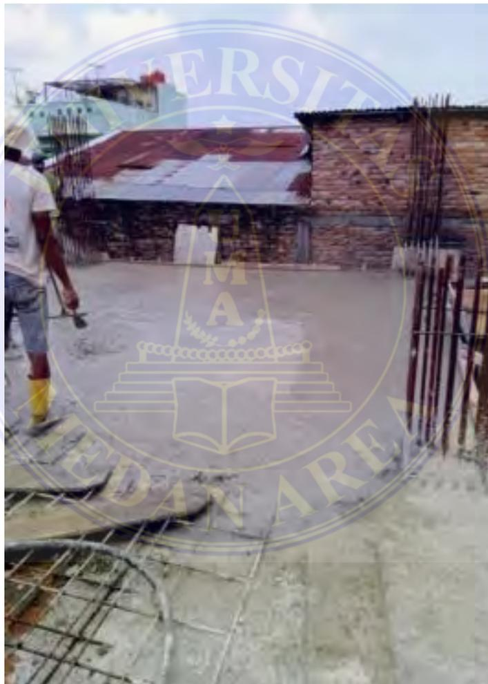
Gambar 3. 30 Pengecoran Pelat Lantai (Dokumentasi Proyek,2025)
