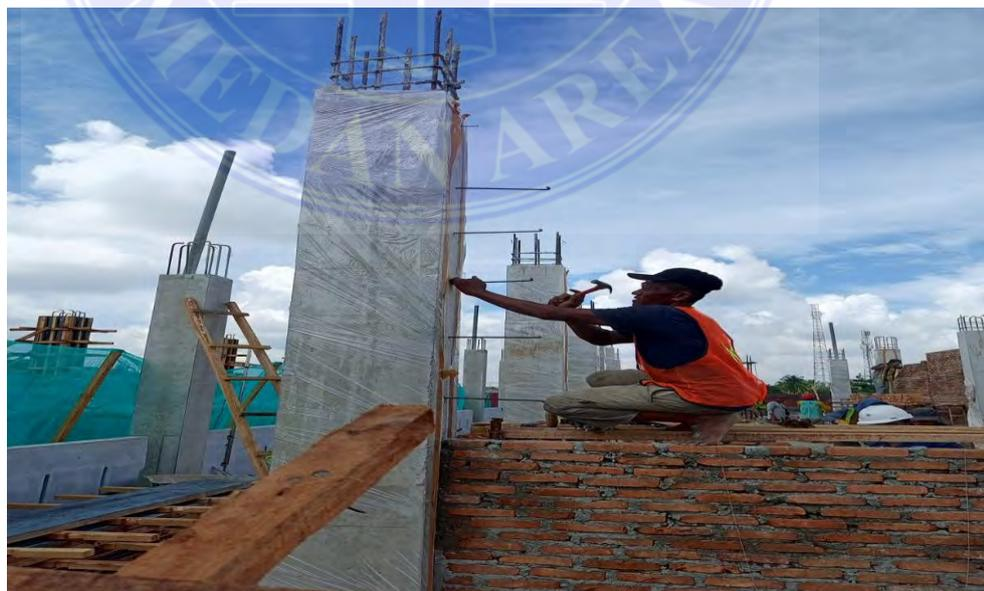
Gambar 3.27 Perawatan Beton Kolom (dokumentasi proyek 2025)
