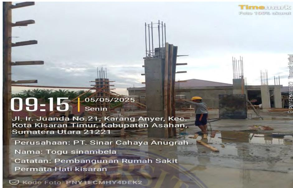
Gambar 3.26 Pembongkaran Bekisting Kolom (dokumentasi proyek 2025)
