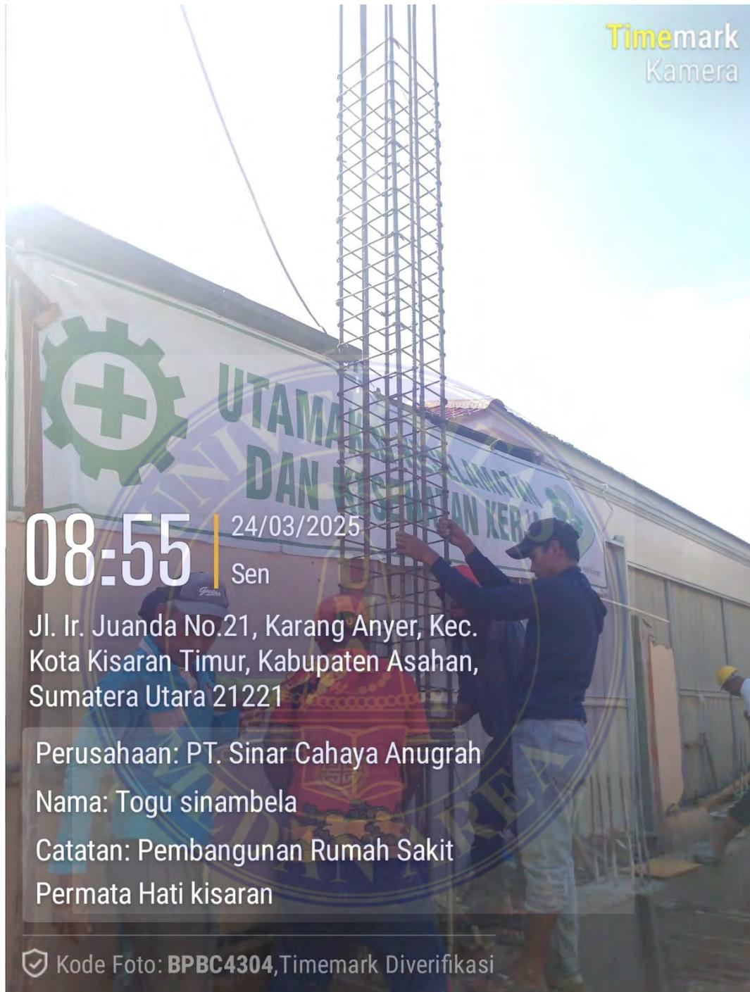
**Gambar pemasangan tulangan kolom**
