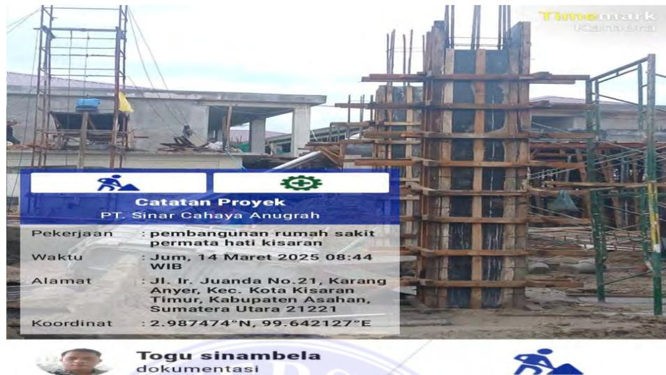
Gambar 3.14 Pemasangan Bekisting Kolom (dokumentasi proyek 2025)
