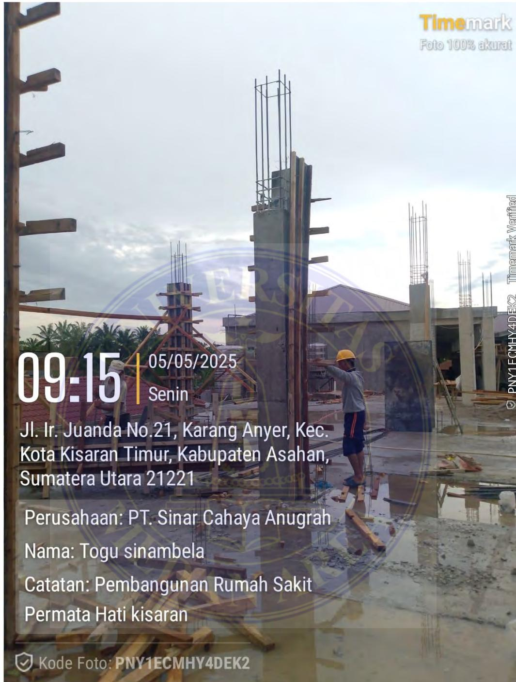
Gambar pembongkaran bekisting kolom
