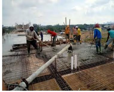
Gambar 36. Pengecoran Pelat (Dokumentasi Proyek, 2025)
