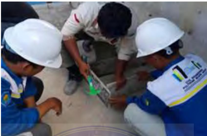
Pembuatan bekisting untuk dudukan elastomer
