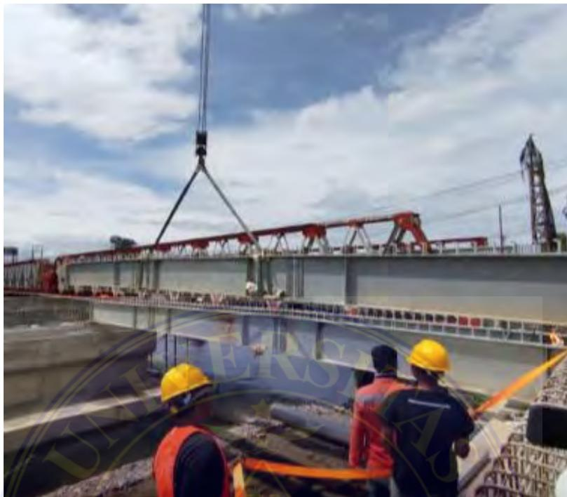
Erection girder pada jembatan A18
