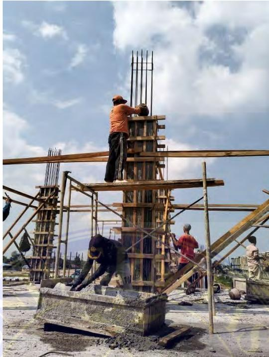
Gambar 7. Proses pengecoran kolom (Dokumentasi Proyek, 2025)
