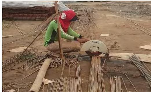
Gambar 15. *Cut Off Machine* (Dokumentasi Proyek, 2025)
