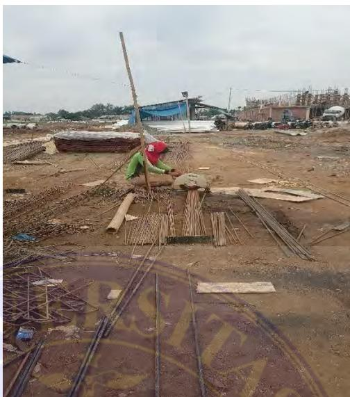
Gambar 3. Proses pemotongan besi (Dokumentasi Proyek, 2025)
