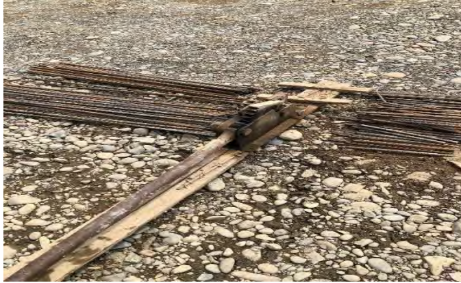
C Gambar 3.5. Bar Cutter (Dokumentasi Lapangan)
