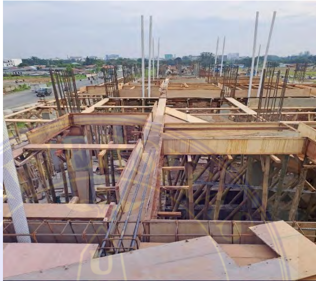
Gambar 3.24. Perakitan tulangan balok (Dokumentasi Proyek, 2025)
