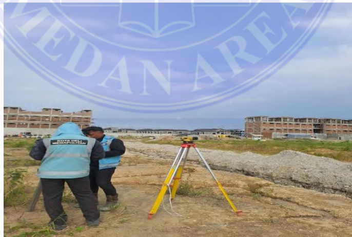
Gambar 3.9. Waterpass (Dokumentasi Lapangan, 2025)
