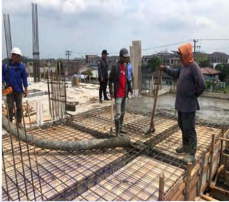
Gambar 3.26 Pengecoran Balok (Dokumentasi Proyek, 2025)
