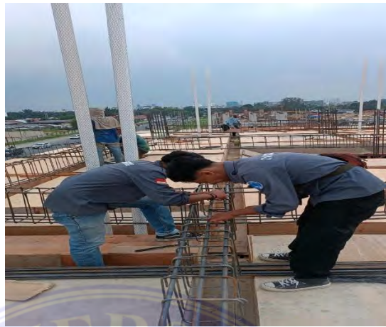
Gambar 3.1 Perakitan tulangan balok (Dokumentasi Proyek, 2025)
