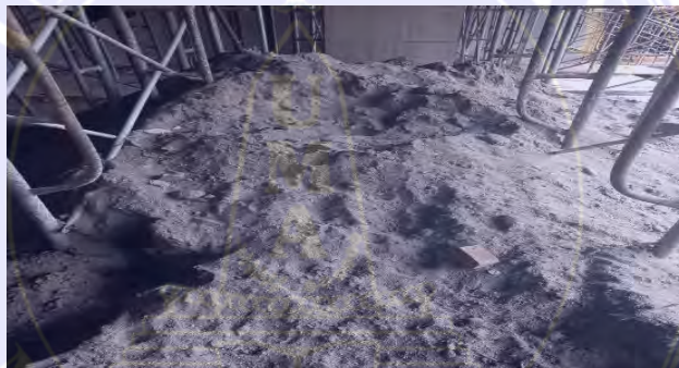
Gambar 3.13. Agregat Halus (Dokumentasi Lapangan, 2025)
