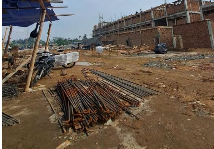
Gambar 3.16. Baja Tulangan (Dokumentasi Lapangan, 2025)
