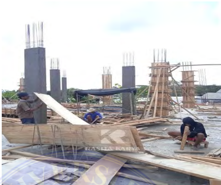
Gambar 3.27 Pelepasan Bekisting (Dokumentasi Proyek, 2025)
