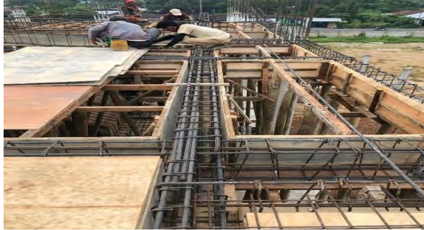
Gambar 3.25. Penulangan Balok (Dokumentasi Proyek, 2025)
