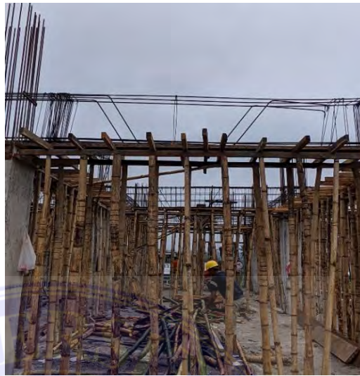
Gambar 3.6. Pemasangan Tulangan (Dokumentasi Proyek, 2025)
