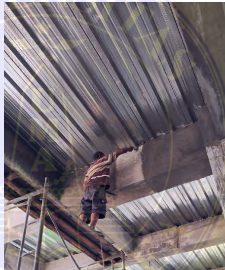
Gambar 3.11 Balok yang sudah jadi (Dokumentasi Proyek, 2025)
