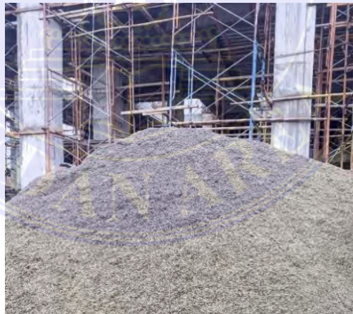
Gambar 2.13. Pasir Beton (Dokumentasi Proyek, 2025)
