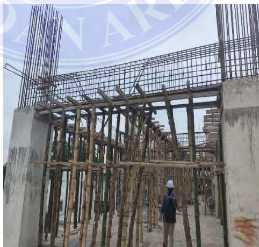
Gambar 3.7. Pemasangan Tulangan Sengkang (Dokumentasi Proyek, 2025)
