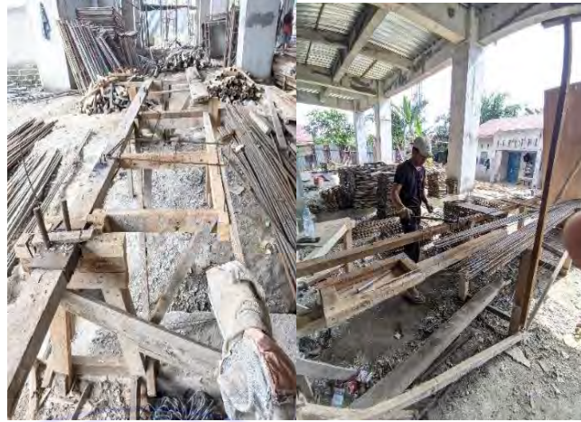
Gambar 3.3. Pembengkokan besi tulangan (Dokumentasi Proyek, 2025)
