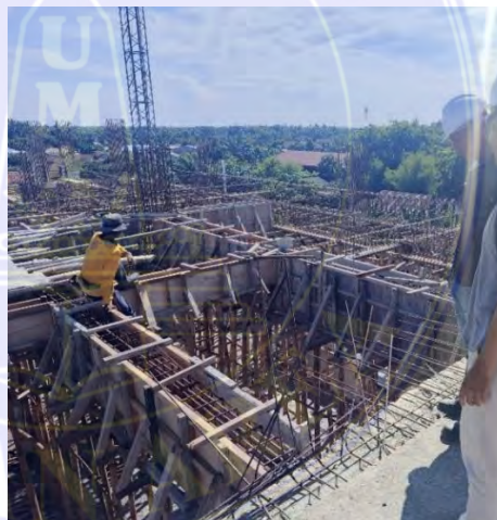
Gambar 3.8. Perakitan bekisting (Dokumentasi Proyek, 2025)
