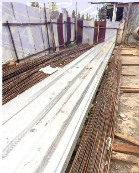
Gambar 2.12. Bondex (Dokumentasi Proyek, 2025)
