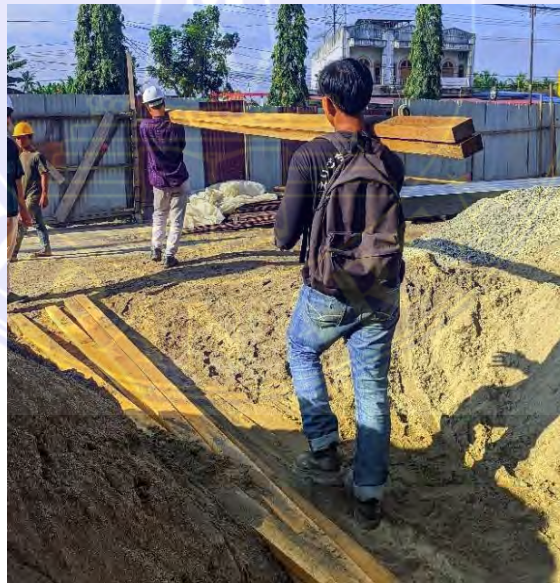
Gambar 2.18. Kayu (Dokumentasi Proyek, 2025)
