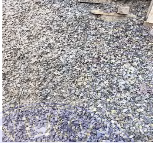
Gambar 2.14. Agregat kasar (Dokumentasi Proyek, 2025)
