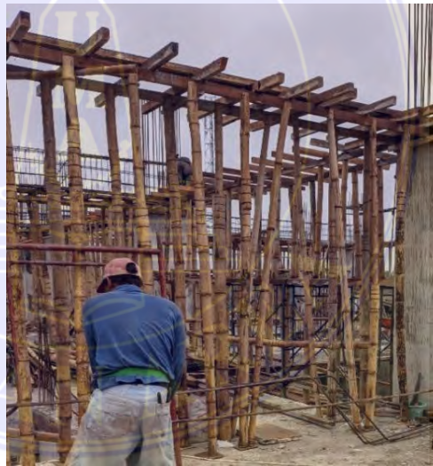
Gambar 3.5. Pemasangan bekisting bambu (Dokumentasi Proyek, 2025)
