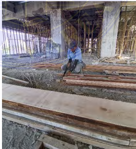
Gambar 3.4. Bekisting balok (Dokumentasi Proyek, 2025)
