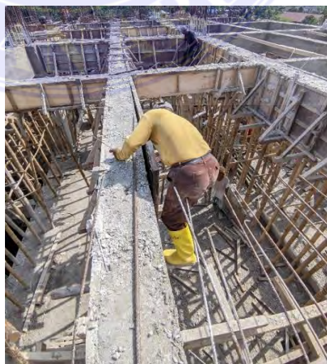
Gambar 3.10. Pembongkaran bekisting (Dokumentasi Proyek, 2025)
