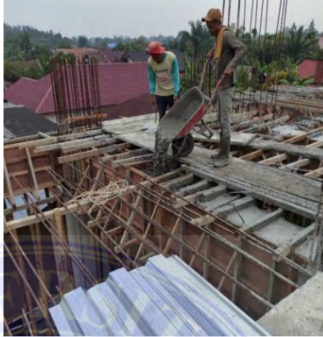
Gambar 3.9. Pengecoran (Dokumentasi Proyek, 2025)
