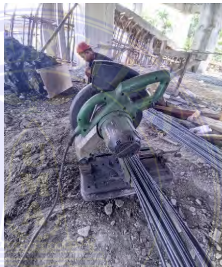
Gambar 3.2. Pemotongan besi tulangan (Dokumentasi Proyek, 2025)
