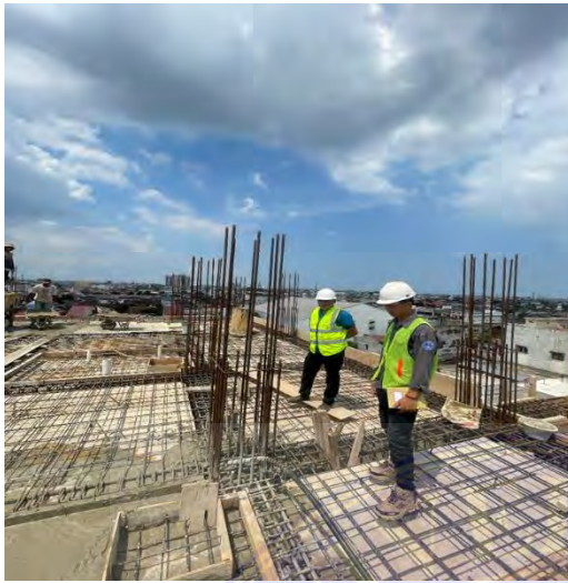
Mengamati pekerjaan pengecoran balok pemasangan tulangan balok
