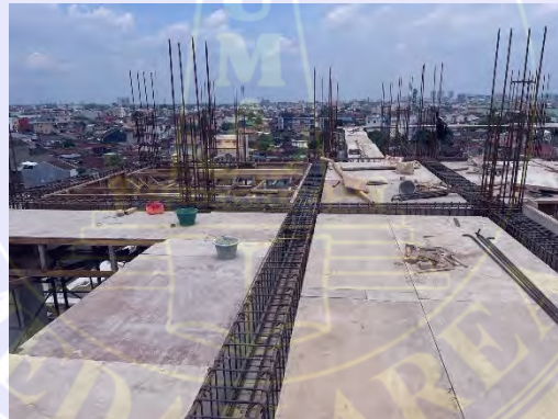
Gambar 3. 8 Bekisting (Dokumentasi Proyek, 2025)
