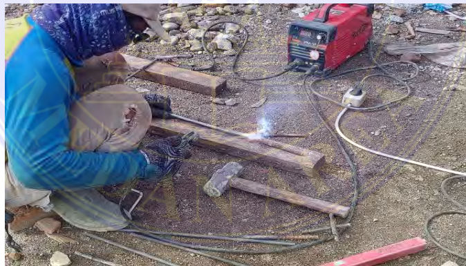
Gambar 3. 12 Las Listrik (Dokumentasi Proyek, 2025)
