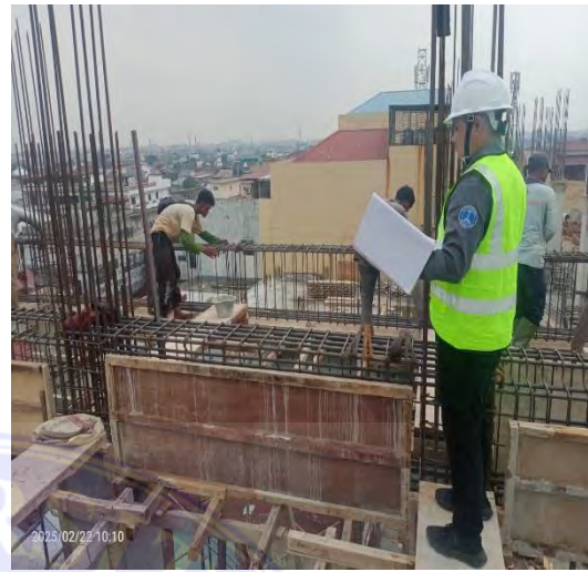
Mengamati pekerjaan pengecoran balok pemasangan tulangan balok
