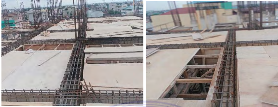
Gambar 4. 1 Pemasangan Bekisting Balok (Dokumentasi Proyek, 2025)
