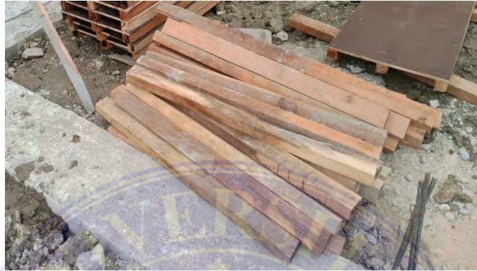
Gambar 3. 28 Kayu (Dokumentasi Proyek, 2025)
