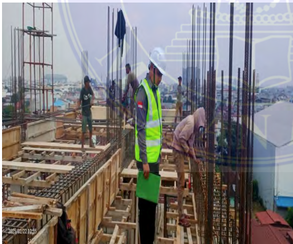
Mengamati pemasangan sengkang pada balok pekerjaan penulangan pelat
