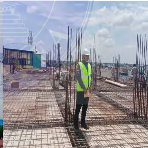
Mengamati pemasangan sengkang pada balok pekerjaan penulangan pelat
