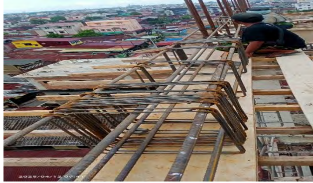
Gambar 4. 2 Pemasangan tulangan balok(Dokumentasi Proyek, 2025)
