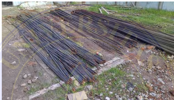
Gambar 3. 22 Besi Tulangan (Dokumentasi Proyek, 2025)
