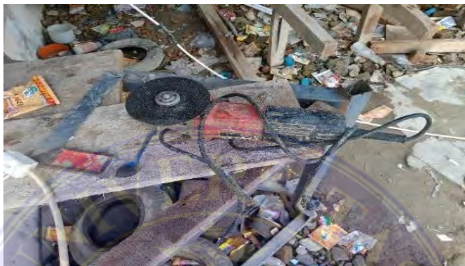
Gambar 3. 20 Gerinda Tangan (Dokumentasi Proyek, 2025)
