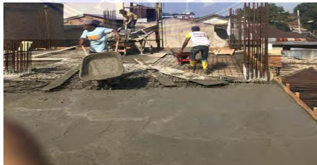
Gambar 4. 3 Pengecoran Balok (Dokumentasi Proyek, 2025)
