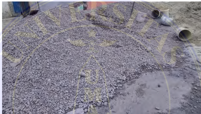
Gambar 3. 25 Agregat (Batu Pecah) (Dokumentasi Proyek, 2025)
