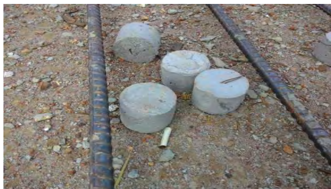
Gambar 3. 27 Beto Decking (Dokumentasi Proyek, 2025)
