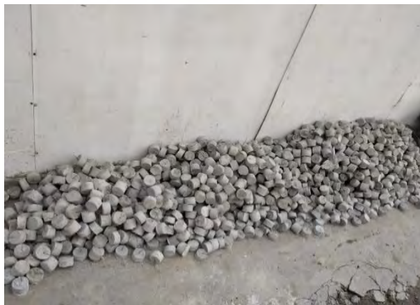
Gambar 3.3.2 Beton Decking (Dokumentasi Proyek, 2025)
