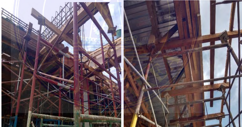
Gambar 3.4 2 Pemasangan Scaffolding
