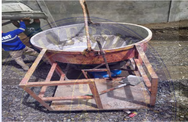
Gambar 3.2. 53 Bucket (Dokumentasi Proyek, 2025)
