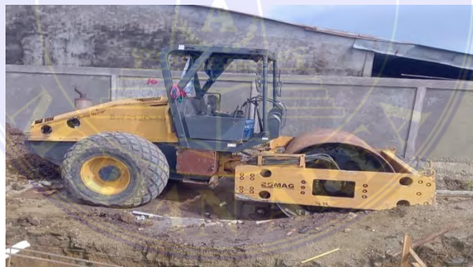
Gambar 3.2. 19 Vibrator Roller (Dokumentasi Proyek, 2025)
