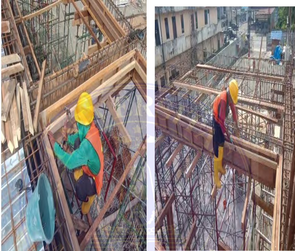
Gambar 3.4 3 Pemasangan Bekisting (Dokumentasi Proyek, 2025)
