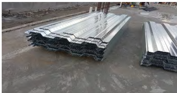
Gambar 3.3 19 Floor Deck (Dokumentasi Proyek, 2025)
