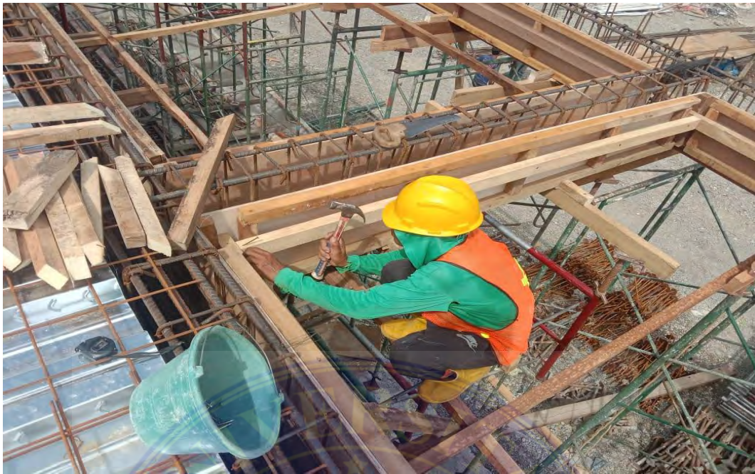
Lampiran 68 Pemasangan Bekisting (Dokumentasi Proyek, 2025)
