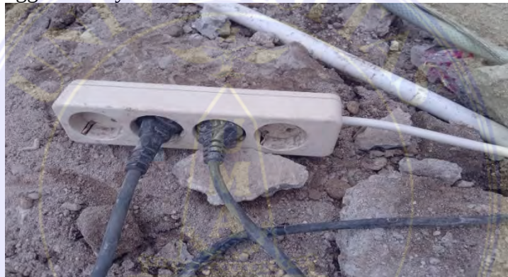
Gambar 3.2. 32 Cok Sambung (Dokumentasi Proyek, 2025)
