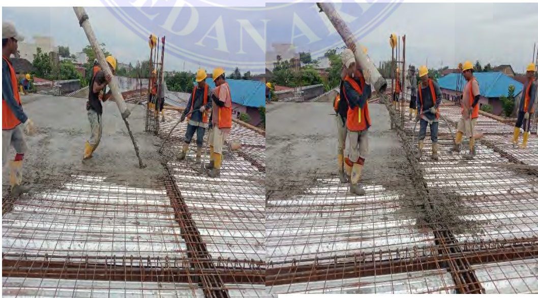
Gambar 3.4 5 Pengecoran Beton (Dokumentasi Proyek, 2025)
