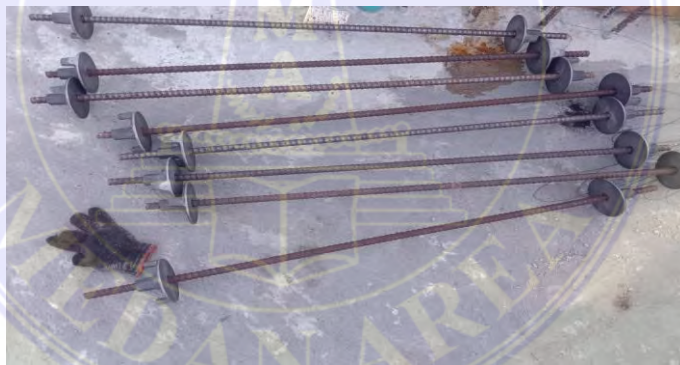
Gambar 3.2. 45 Tie Rod (Dokumentasi Proyek, 2025)
