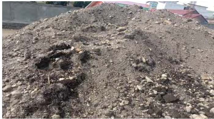
Gambar 3.3 5 tanah Timbunan (Dokumentasi Proyek, 2025)
