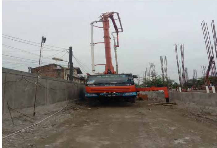
Gambar 3.2. 35 Concrete Pump (Dokumentasi Proyek, 2025)
