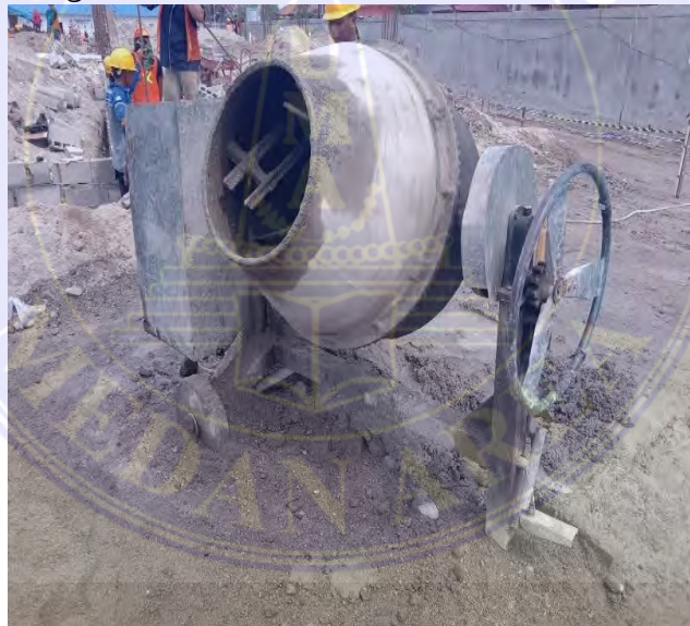
Gambar 3.2. 13 Molen Mini Mixer (Dokumentasi Proyek, 2025)
