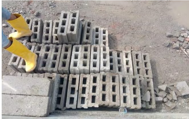
Gambar 3.3 10 Batako (Dokumentasi Proyek, 2025)
