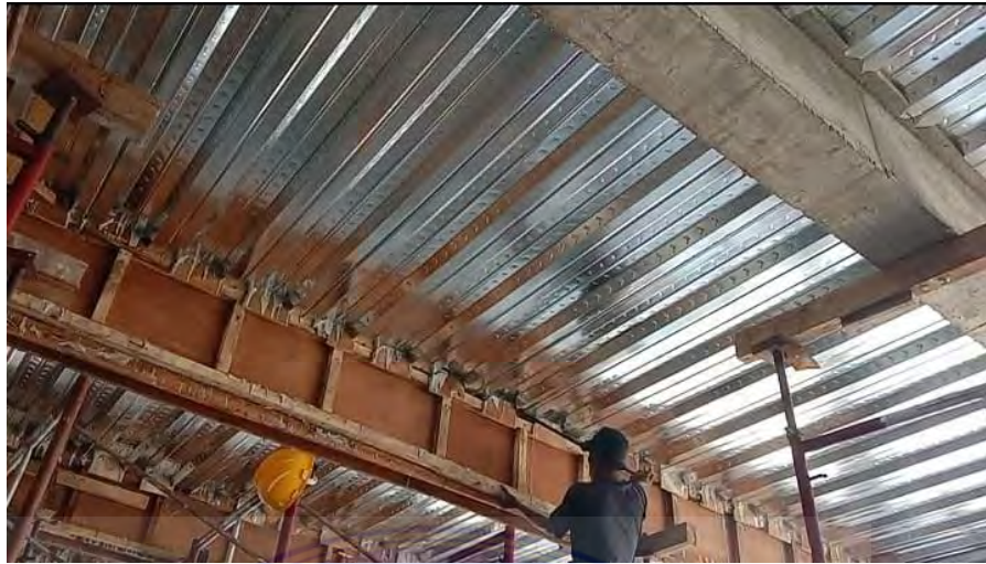
Gambar 3.4 7 Pembongkaran bekisting (Dokumentasi Proyek, 2025)
