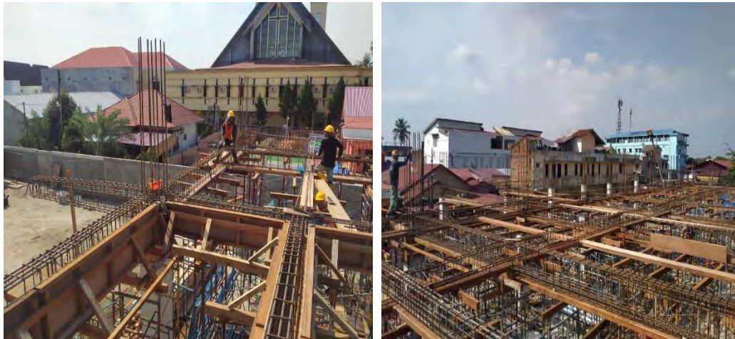
Gambar 3.4 4 Perakitan & Pemasangan Tulangan (Dokumentasi Proyek, 2025)
