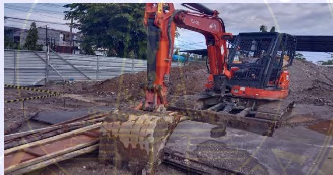
Gambar 3.2. 21 Excavator (Dokumentasi Proyek, 2025)
