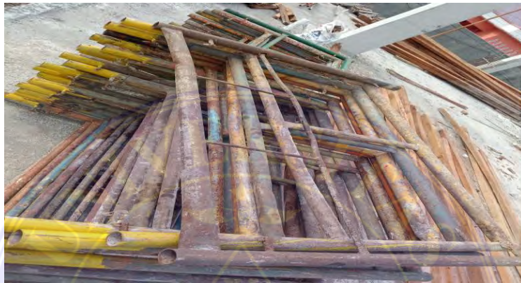
Gambar 3.2. 51 Scaffolding (Dokumentasi Proyek, 2025)
