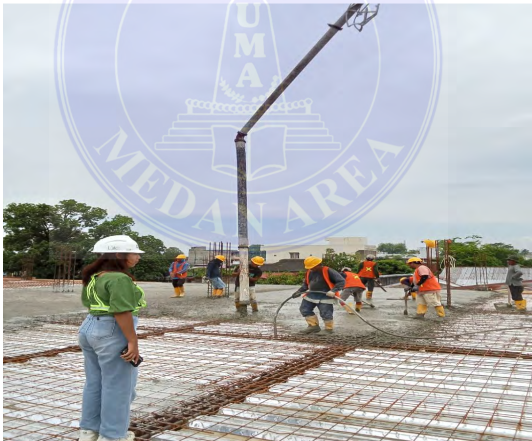
Lampiran 4 Pengecoran (Dokumentasi Proyek, 2025)
