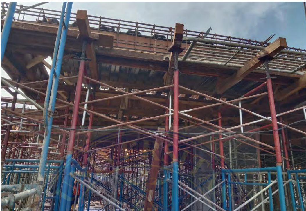
Lampiran 1 Pemasangan scaffolding (Dokumentasi Proyek, 2025)
