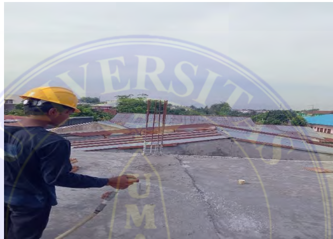
Gambar 3.4 6 Perawatan ( Curing ) Beton (Dokumentasi Proyek, 2025)
