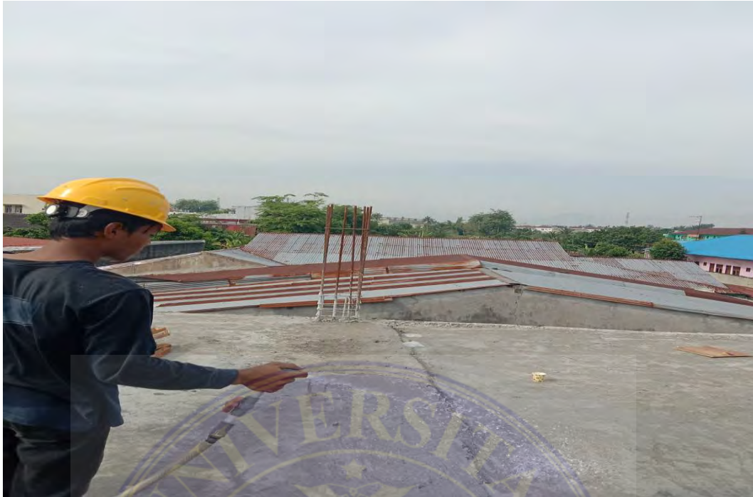
Lampiran 5 Curing Beton (Dokumentasi Proyek, 2025)
