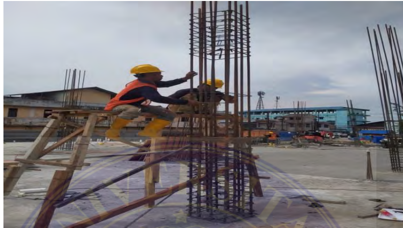
Gambar 3.3.8 Bekisting (Dokumentasi Proyek,2025)
