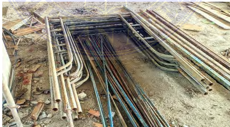
Gambar 3.3.19 Scaffolding (Dokumentasi Proyek,2025)
