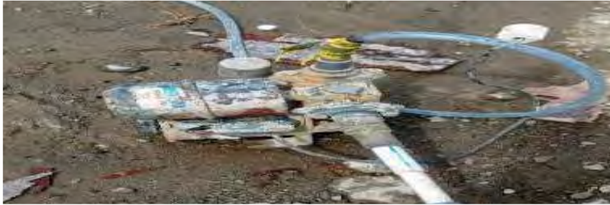
Gambar 3.3.26 Mesin Pompa Air (Dokumentasi Proyek,2025)
