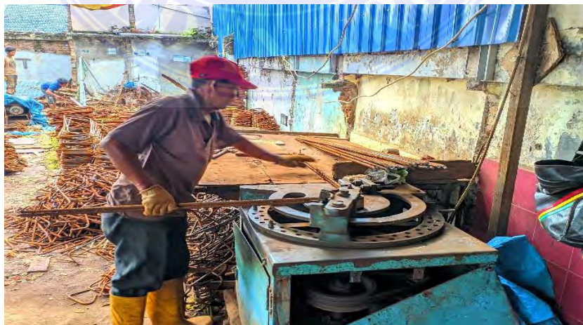
Gambar 3.3.23 Bar Bender (Dokumentasi Proyek,2025)
