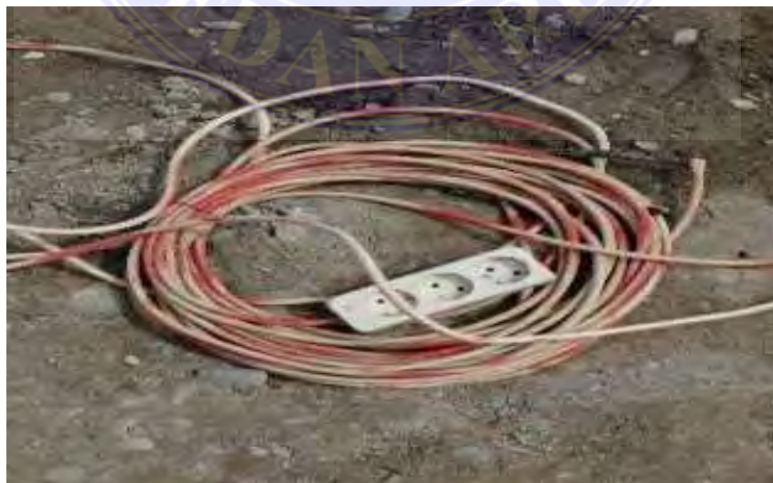
Gambar 3.3.21 Cok Sambung (Dokumentasi Proyek,2025)
