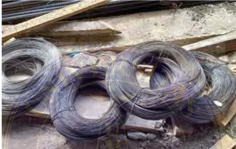
gambar 3.4 3 Kawat (Dokumentasi Proyek,2025)
