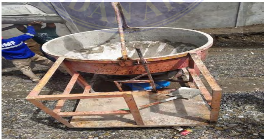
Gambar 3.3.25 Bucket Cor (Dokumentasi Proyek,2025)
