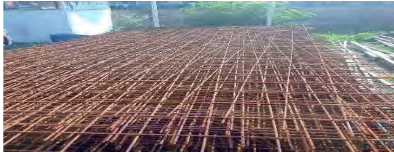
gambar 3.4 14 Wiremesh (Dokumentasi Proyek,2025)
