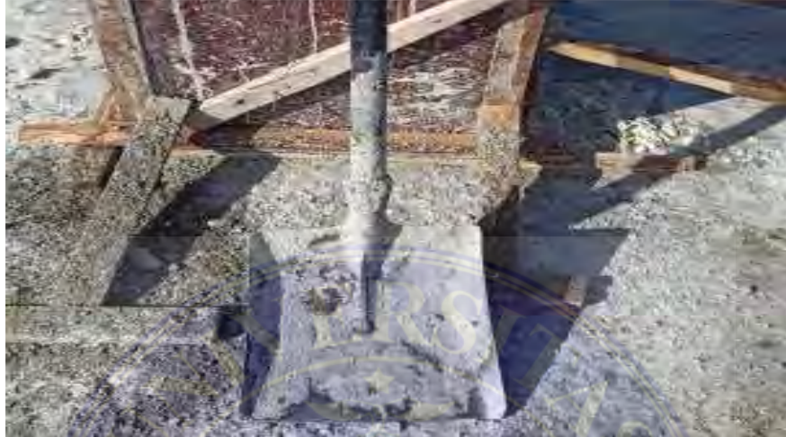
Gambar 3.3.18 sekop (Dokumentasi Proyek,2025)
