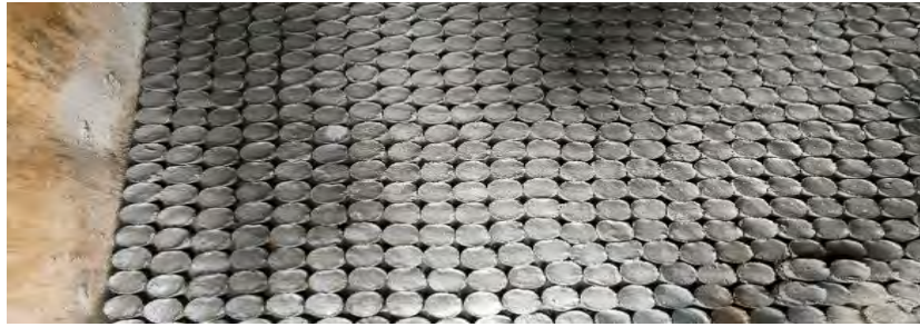
gambar 3.4.11 Beton Decking (Dokumentasi Proyek,2025)
