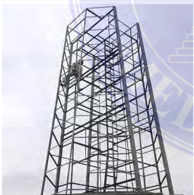
Gambar 3.12. Pemasangan Besi Hollow Menara
