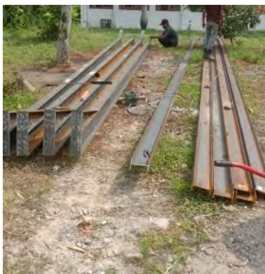
Gambar 3.8. Pengecekan Profil IWF
