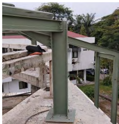
Gambar 3.9. Pemasangan Profil IWF
