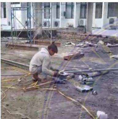
Gambar 3.10. Pemotongan Hollow 40x40mm
