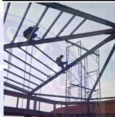
Gambar 3.11. Pemasangan Reng Hollow
