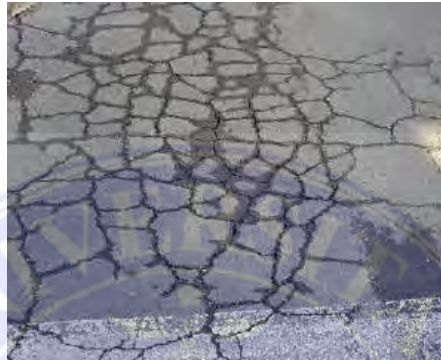
Gambar 4. Retak Kulit Buaya (Prayitno, 2020)
