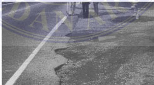
Gambar 11. Retak Cacat Tepi Perkerasan
