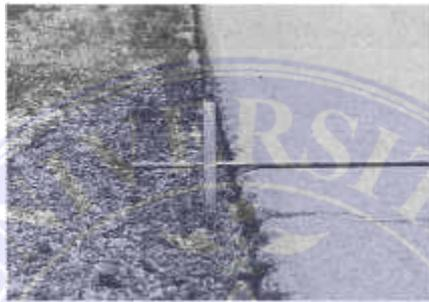
Gambar 13. Kerusakan Penurunan Pada Bahu Jalan
