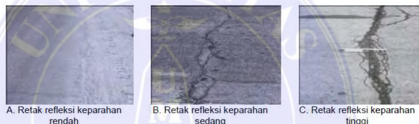
Gambar 9. Retak Refleksi Sambungan (Kementerian Pekerjaan Umum dan Perumahan Rakyat, 2016)
