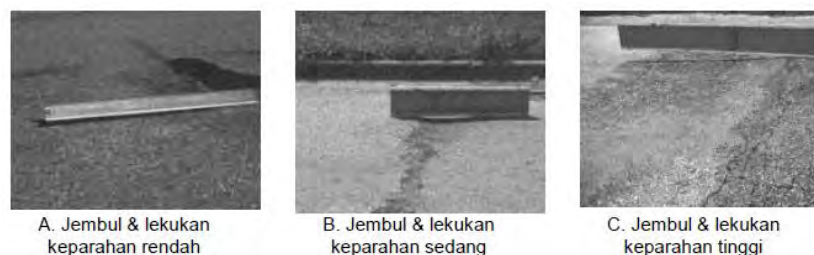
Gambar 5. Jembul dan Lekukan (Kementerian Pekerjaan Umum dan Perumahan Rakyat, 2016)
