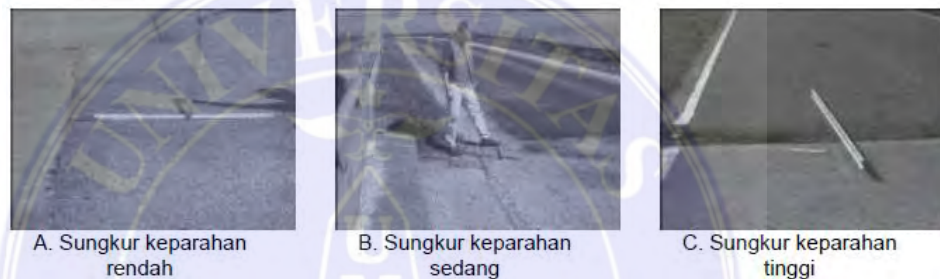
Gambar 17. Sungkur (Kementerian Pekerjaan Umum dan Perumahan Rakyat, 2016)
