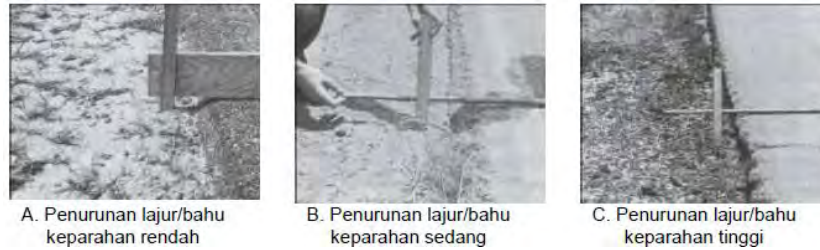
Gambar 10. Penurunan Lajur/Bahu (Kementerian Pekerjaan Umum dan Perumahan Rakyat, 2016)
