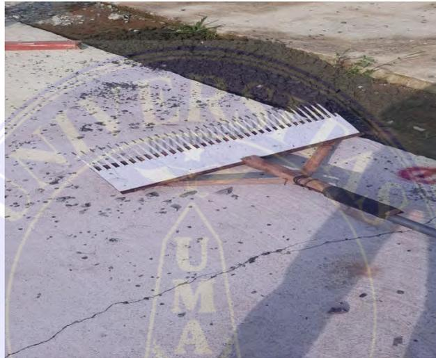
Gambar 3.8 Pembuatan Tekstur secara manual
