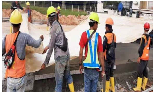
Gambar 3.7 *Pemasangan Geotextile*
