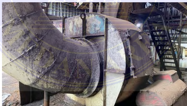
Gambar 3. 38 Fiber Cyclone Fan
