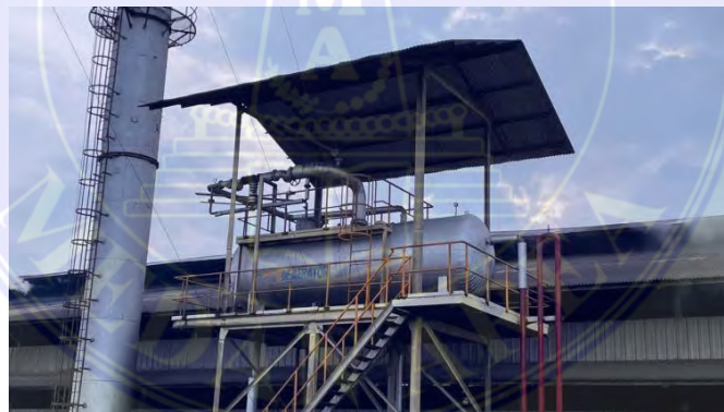
Gambar 3. 59 Thermal Dearator
