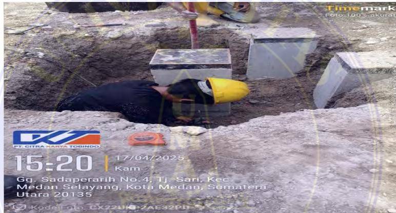
Gambar 3. 26 Proses pemasangan sensor getar
