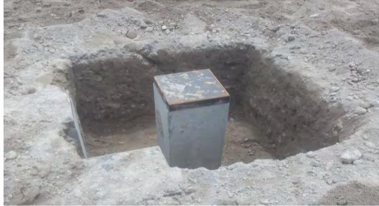
Gambar 3. 25 Tiang pancang yang siap untuk di uji
