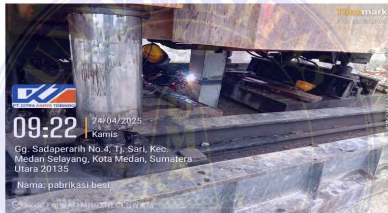
Gambar 3. 23 Penyambungan tiang pancang dengan las
