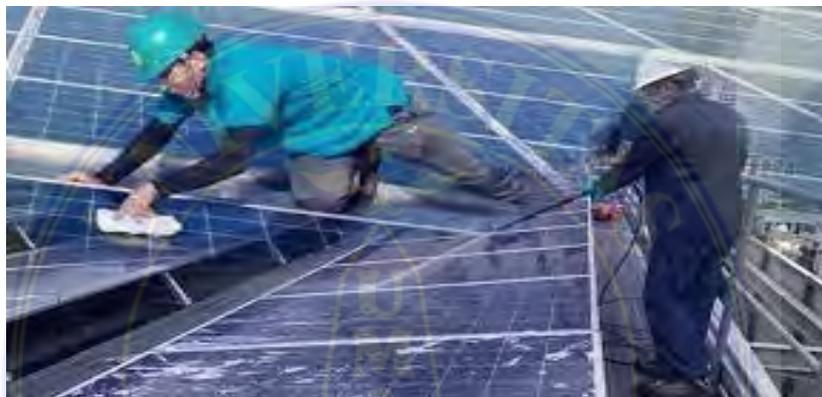
Gambar 2.2 Pembersihan Permukaan Panel Surya
