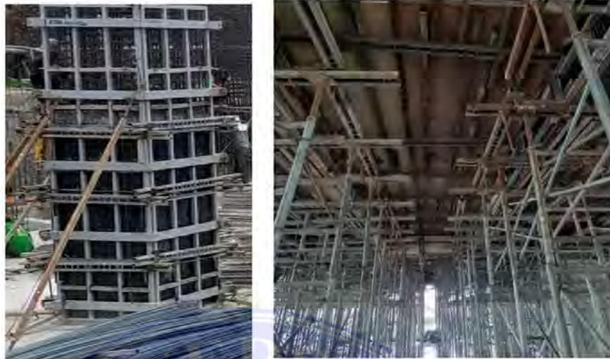
Gambar 2. Bekisting Semi Sistem (Dokumentasi Proyek, 2024)
