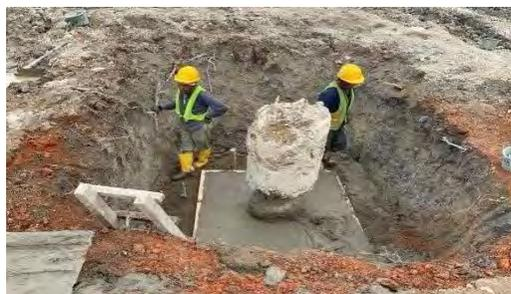
Gambar 33. Pengecoran *Pile Cap*
