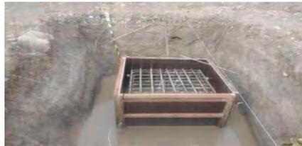
Gambar 32. Penulangan *Pile Cap*
