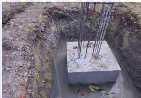
Gambar 34. Pelepasan *Bekisting*
