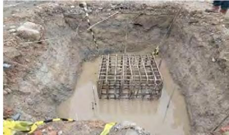
Gambar 31. Penulangan *Pile Cap*
