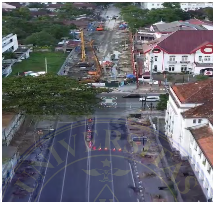
Gambar. 1 Persimpangan Jalan HM Yamin Sebelum adanya underpass
